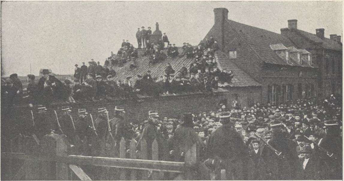
FRAMFÖR INGÅNGEN TILL SCHAKTET SALLAUMINES OMEDELBART EFTER KATASTROFEN.
