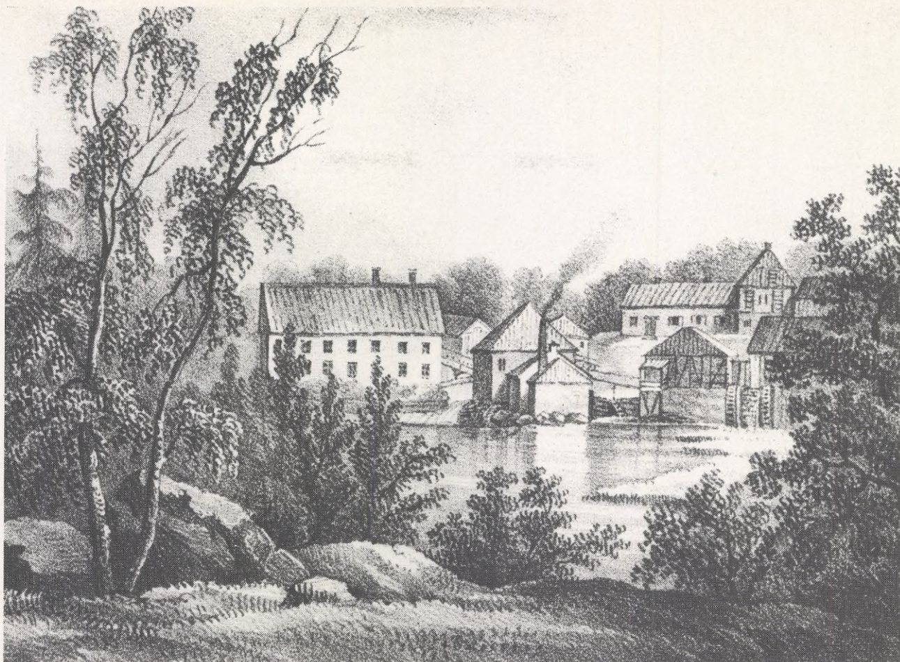
Klippans pappersbruk i Skåne på 1840-talet. Tvåvåningshuset t v på bilden är valshuset med 4 holländare. Mitt på bilden invid strömmen ångpannehus med en 5 m hög skorsten. Bakom maskinhuset fanns vårt lands första pappersmaskin uppställd. Litografi från 1840-talet.
