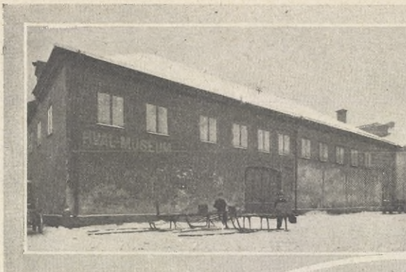
DEN GAMLA, NU UT- RYMDA BYGGNA- DEN VID HOLLÄN- DAREGATAN.
