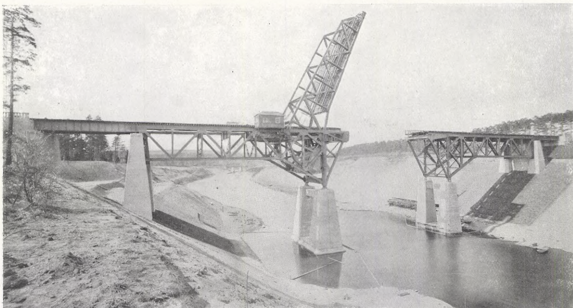
DEN NYA BRON ÖVER SÖDERTÄLJE KANAL. Hela den dubbelspåriga klaffbron, sedd med dess 610-ton tunga klaff uppfälld. Öppnad för trafik den 1 oktober. — Text å sid. 47. — Efter fotografi. — Klippe. Hengt Silfversparre.
