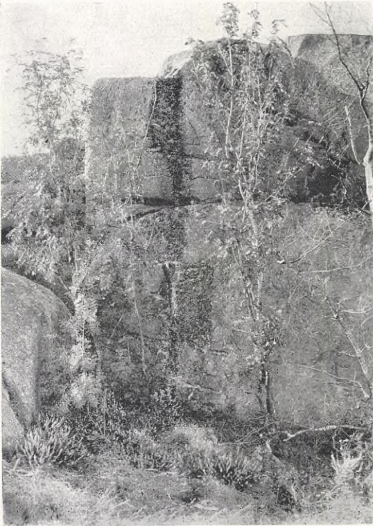
LÖDRÄT GRANITVÄGG MED LAFKLÄDDA SIPPERVATTENSYTOR.
