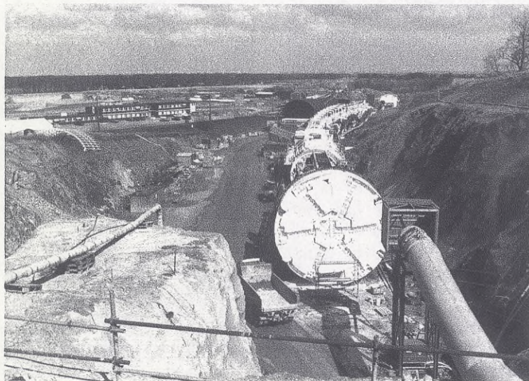
Bild 1. Tunnelborrmaskinen "Hallborr" som med en hastighet av 100 meter per vecka skulle "äta sig" genom berget. Entreprenören Kraftbyggarna fick dock problem med borren. Foto: Birger Lallo.
