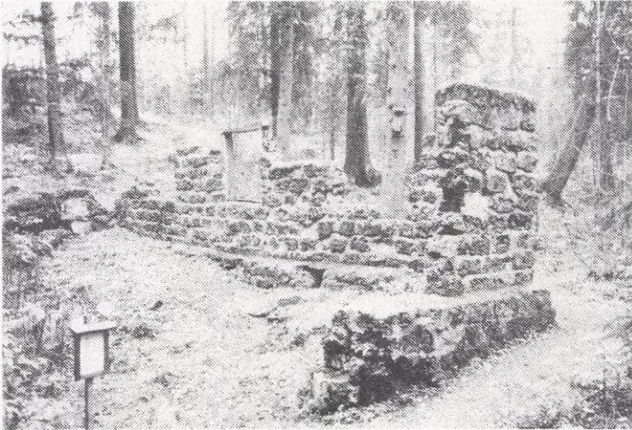
Fig 7. Ruinerna av bessemerverket i Siljansfors. Foto A Götlind 1997.
