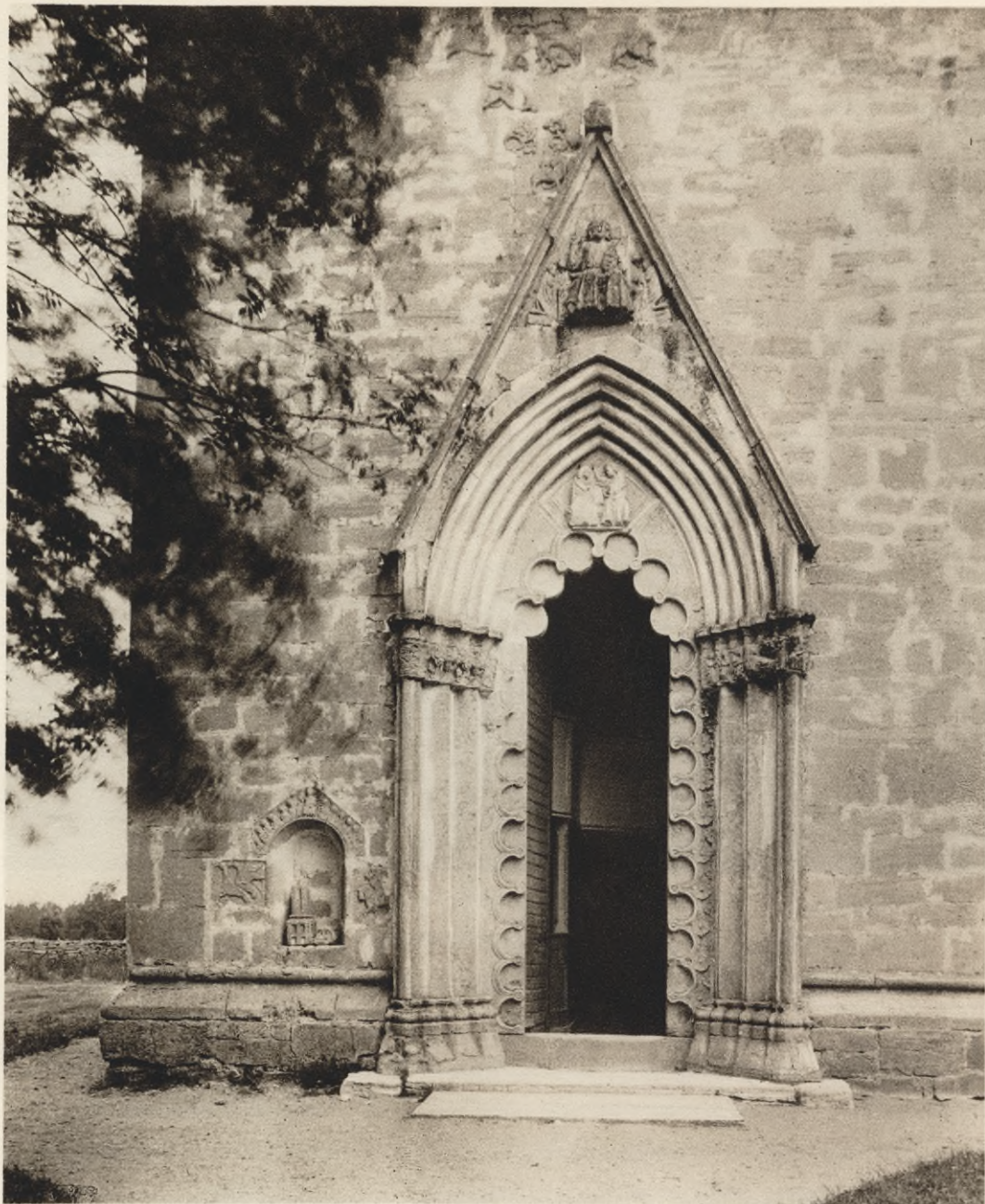
Pl. 8. Gotisk portal på Väle kyrka. Den ursprungliga kyrkan uppfördes av kalksten under 1100-talet.
