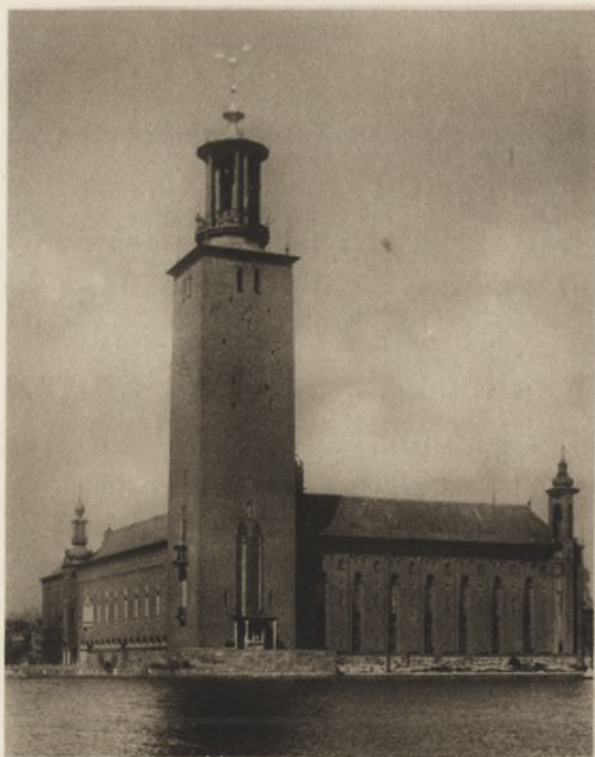
Fig. 71. Stockholms stadshus. Uppfört av Ragnar Östberg. Färdigt 1923.
