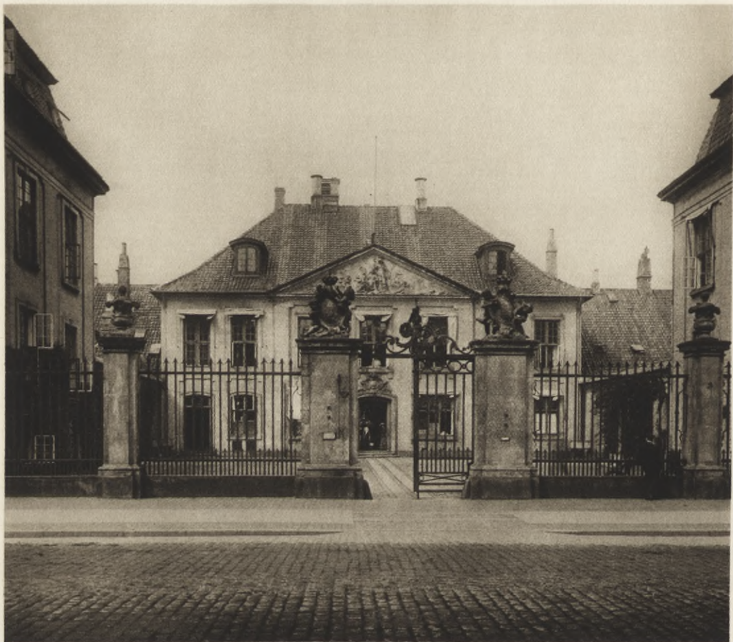
Pl. 120. Frederikshospitalet i Köpenhamn. Uppfört av Nicolai Eigtved. 1700-talets mitt.
