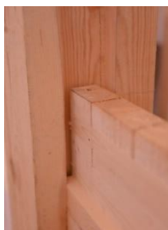
Fig. 74, Treskikts KL-skiva 82 mm monterad i spår på stolpe. Fals i skiva för sammanfogning med övre KL-skiva.
