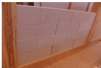
Fig. 52, LB 75-block murade som fackfyllnad i spåralternativet.
