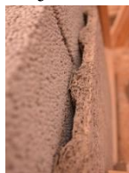
Fig. 56, TUC ventilerad putsbärare 50 mm, utanpå LK 120 mm block.
