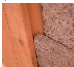
Fig. 57, TUC 25 mm, här utanpå TUC-element 150 mm.
