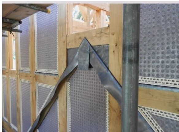
Fig. 18, Verkligt exempel på i3 Infill Panel System, (Oakwrights 2016).
