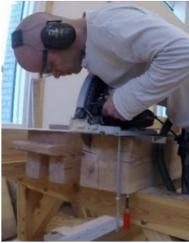
Fig. 43, Falsa med cirkelsåg på skena.
