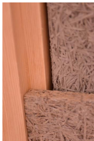
Fig. 61, TUC-element 150 mm med standard 25 mm på, i fals.
