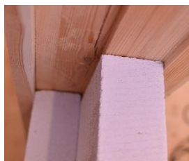
Fig. 53, LB 75-block murade som fackfyllnad i falsalternativet.
