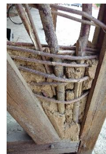
Fig. 22, Flätverk av hasselstörar med lerfyllning, fästa med list, likt Fig. 21, övre.
