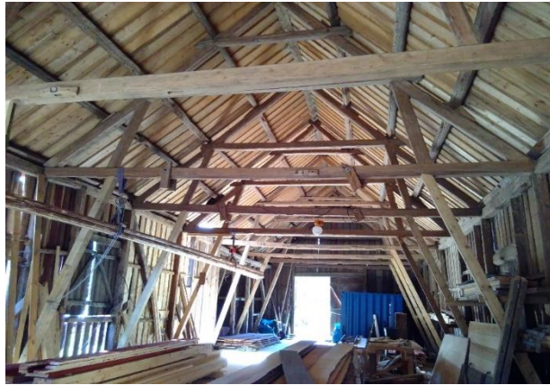
Fig. 30, Stolpverk är enligt Werner, en bärande skelettstomme med panel utanpå (1924, s. 3). Del av lada på landeriet i Kvibergsnäs, Göteborg.
