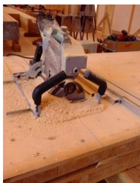
Fig. 73, Kapning av treskikts KL-skiva 82 mm med kedjesåg på skena.
