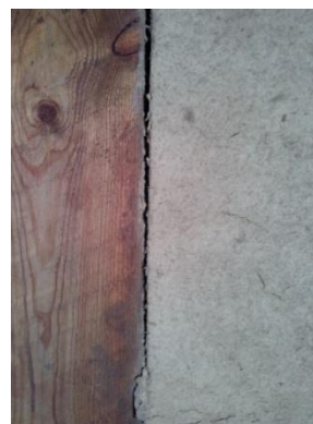
Fig. 5, Torkspricka mellan stolpe och fackfyllnad av flätverk med lerklining.
