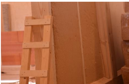
Fig. 77, Larsen truss (Rubell 2016, s. 16) lutad mot den lösning som genomfördes i undersökningen, hyvlade 45 x 120 mm regler, med PC 60 skiva och puts utanpå samt en 12 mm plywood innanför.
