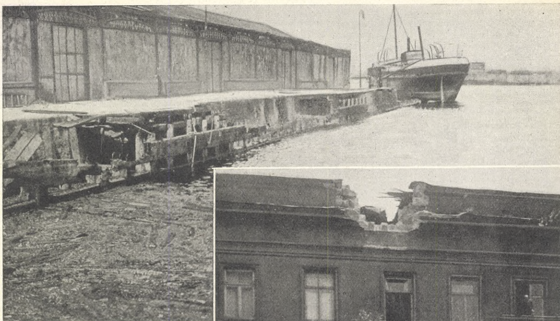
Del af den förstörda hamnanläggningen.
