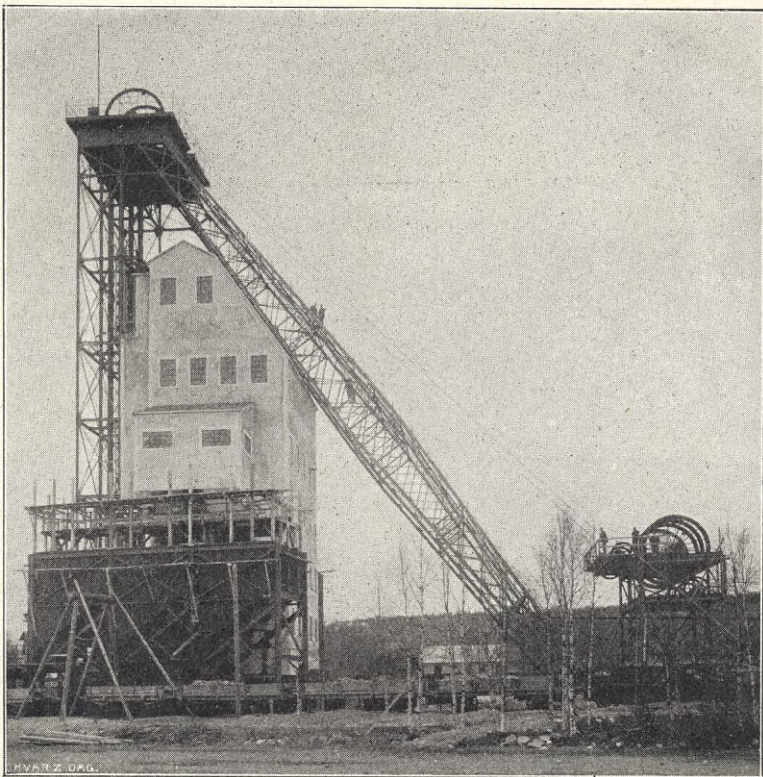
FRÅN GRÄNGESBERG: Den nya, jättelika malmelevatorn, från hvilken ett helt järnvägståg skall kunna lastas på tio minuter.
