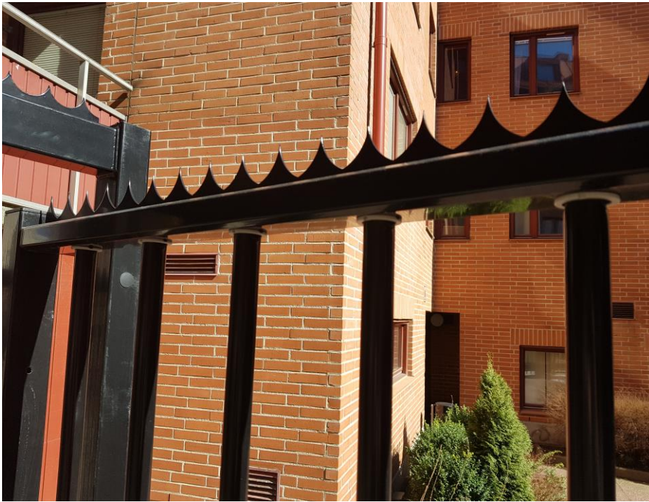
Vässade staket vid Nedre Kvarnhusgatan
