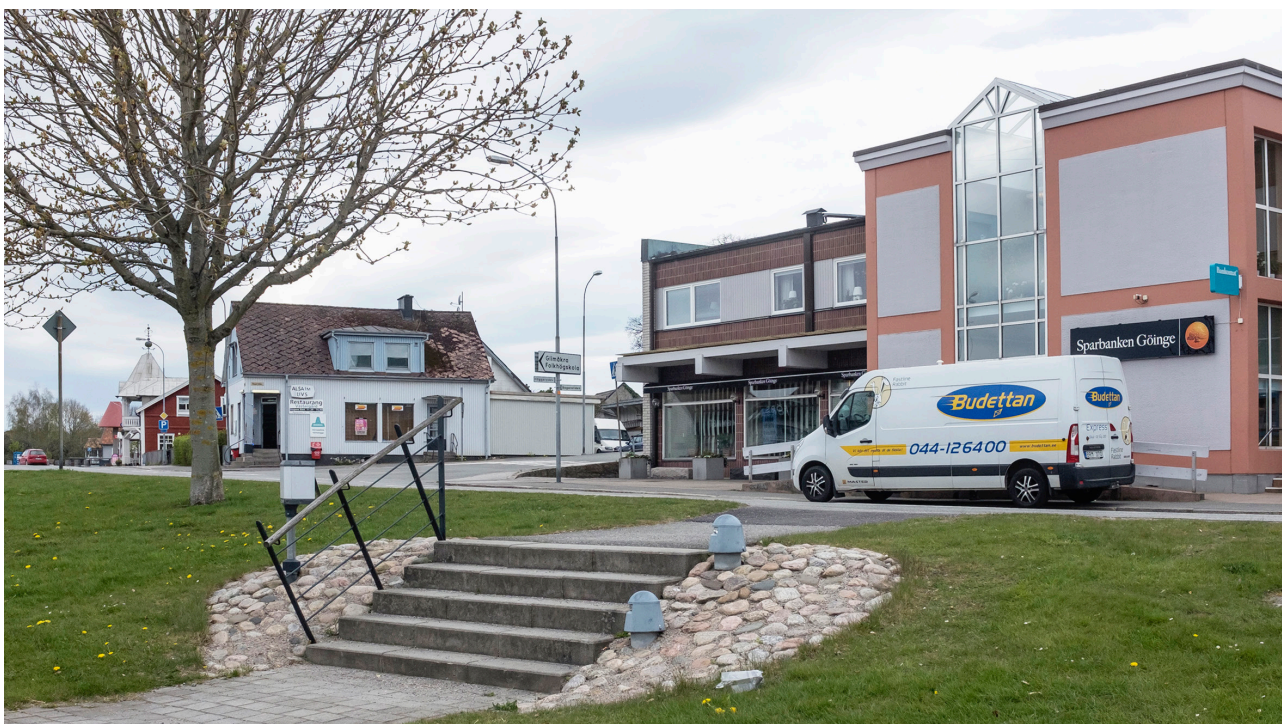
Fig. 45. Ovan: De centrala delarna av Glimåkra, Storgatan. Postmodernismen och dess tillbyggnad präglar Sparbanksbyggnaden. Foto: M. Svensson, 2017
