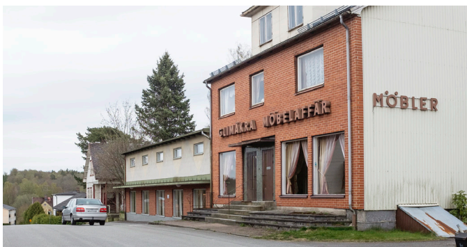
Fig. 44. Vänster: På höjden av Hantverksgatan fanns tidigare tiotalet affärsrörelser och hantverkare. Nu är de alla nedlagda men byggnaderna, de tidstypiska detaljerna och de intakta interiörerna är fortfarande värda att bevara. Foto: M. Svensson, 2017
