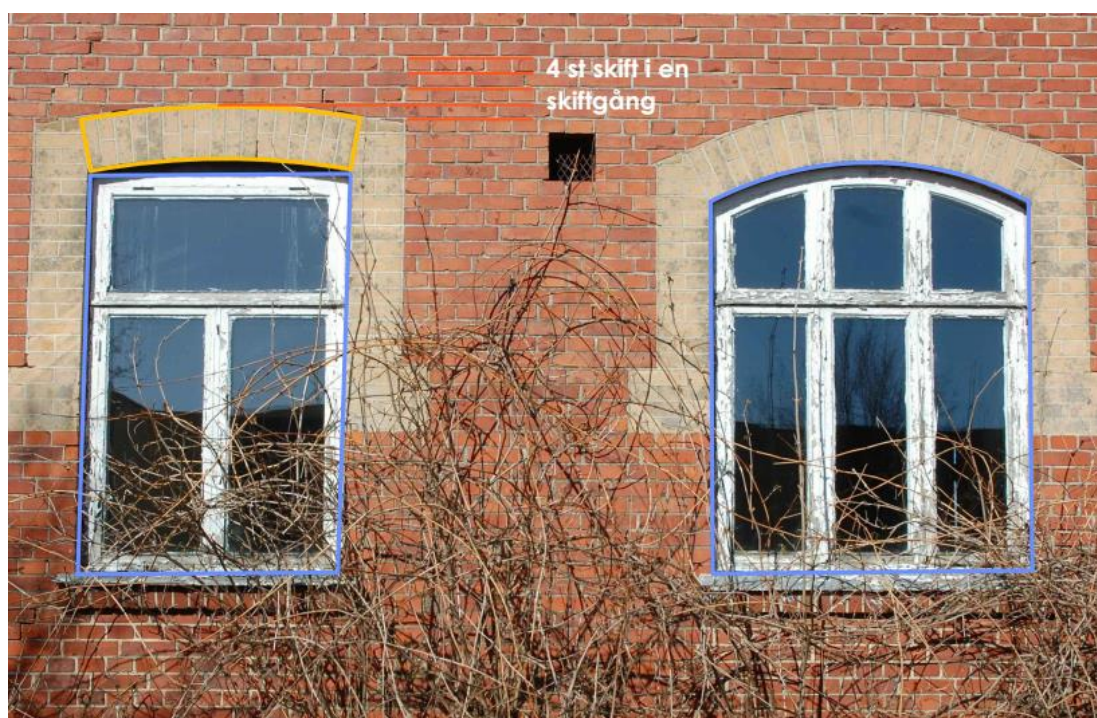
Figur 20. Ett lågt valv med rak fönsterbåge och ett högt valv med rund fönsterbåge på hus nr. 7. Röda linjer förklarar konceptet skiffgång och pekar ut valvringens inpassning i skiffgången.
