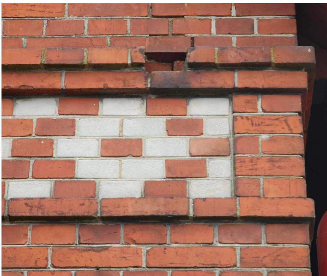
Figur 17. Hörnet av frisen på hus nr. 8. Den egentliga frisen kragar in ett delsteg från vägglivet, och listen ovanför kragar ut totalt ett mursteg från denna yta.
