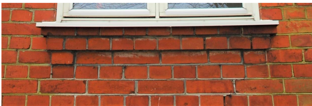
Figur 19. Konsolförsedd fönsterbänk som kragar ut i tre skift – "konsolbänk" – på hus nr. 8.
