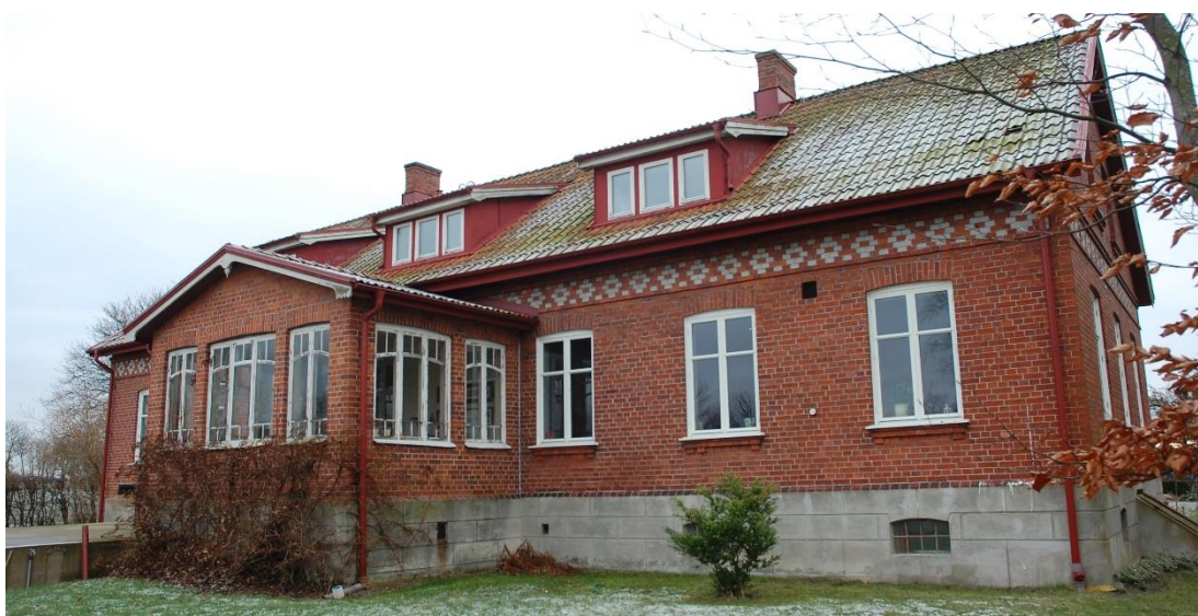
Figur 5. Ett av de nyare, mer högresta husen är hus nr. 4. I bildens nedre högra kant syns hur sockeln skjuter fram från vägglivet.
