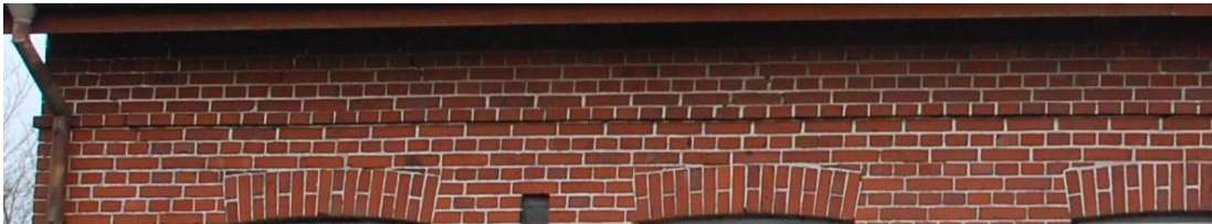
Figur 22. Ytermuren på hus nr. 9 har en enkel gördellist och ansluter rakt till takets undersida
