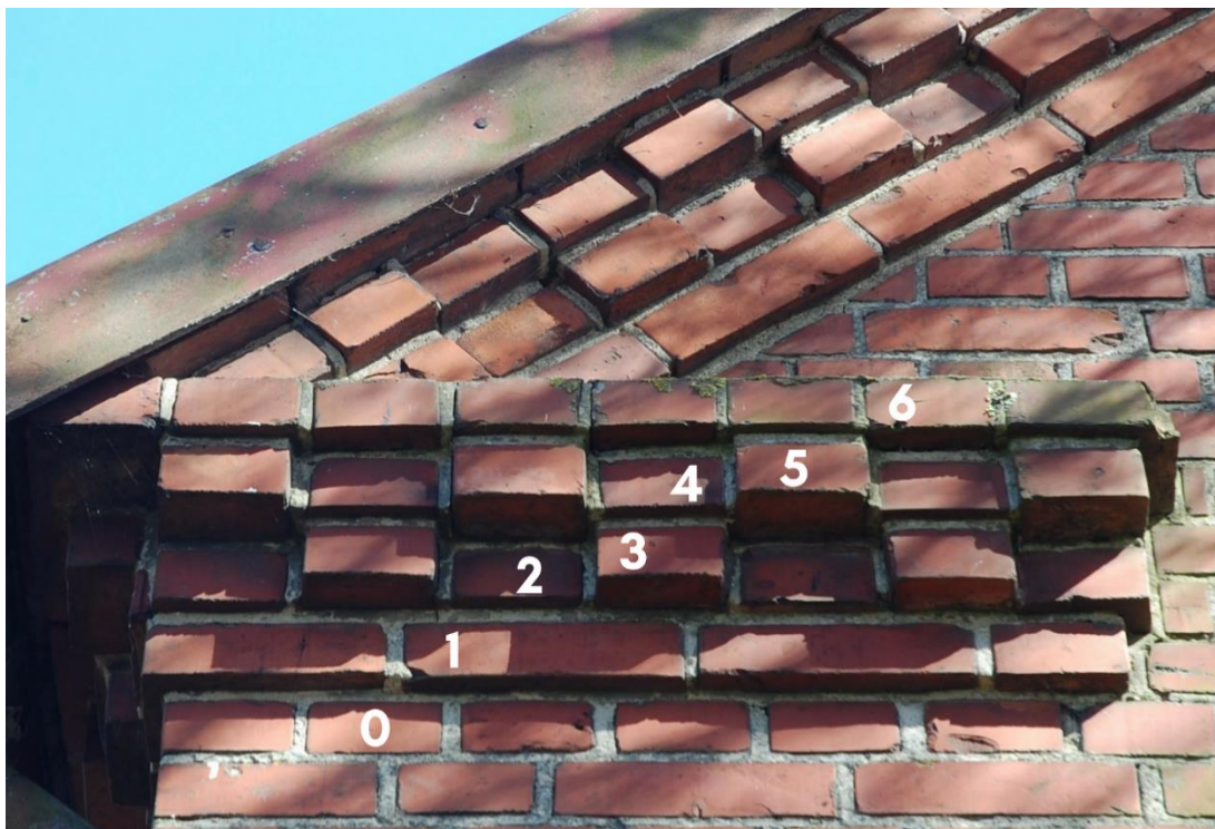
Figur 16. Takgesims i ovanligt många nivåer av utkragning, på hus nr. 7
