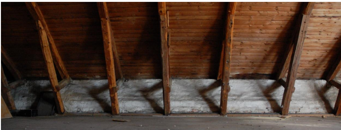
Figur 23. Murkrönet och takgesimsens insida sedd från vinden på hus nr. 7
