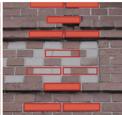
Figur 10. Kryssförbandet fortsätter sin rytm som om det inte hade blivit avbrutet av frisen
