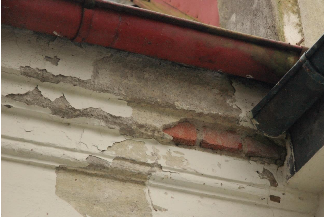
Figur 21. Murkrönet kragar ut mot takkanten på hus nr. 1
