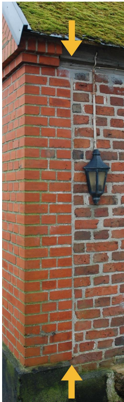
Figur 15. Anslutning mellan nyare gavel och äldre långsida på hus nr. 5
