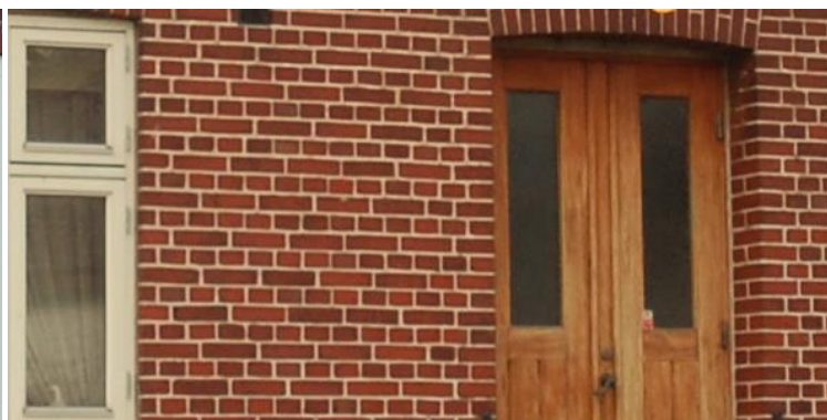
Figur 14. Blandade avslut vid muröppningar på hus nr. 9. Till skillnad från fönstret sitter dörren långt indragen med blottade smyggar. Valet av avslut påverkar inte smygans utseende, men väl hur kraftigt smygens hörn ser ut. Det mer exponerade hörnet kan ha motiverat muraren att göra ett mer arbetat avslut utan pettringar.
