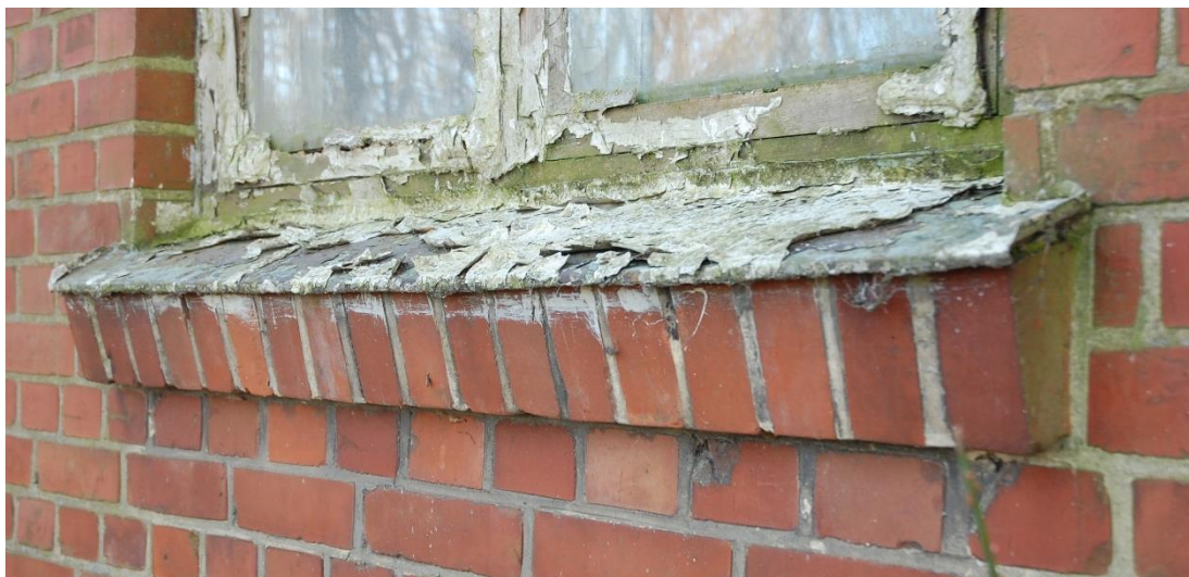
Figur 18. Fönsterbänk av lutande rullskift – "Rullbänk" – på hus nr. 7. Längst ut till höger syns att bänkens lutning gör att den upptar två hela skift i den kringliggande muren. Så har muraren alltså löst problemet med att ett rullskift annars inte passar in i skiftgången.
