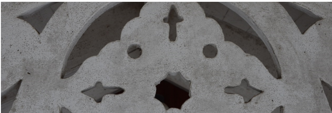
Mitt i bilden kan man se ett svagt streck som är skarven. Man ser även hur delar av mönstret är ojämnt sågat.
