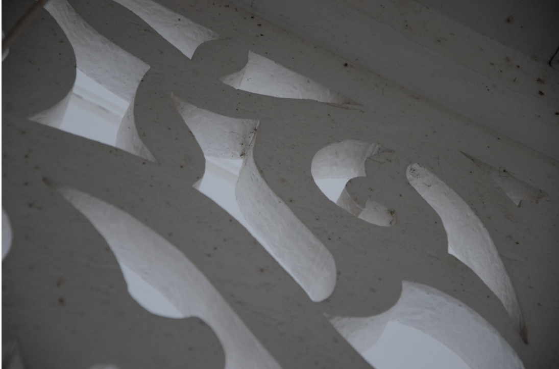
Dekoren har en helt slät yta som är slipad och sågad. Man ser också spåren efter färgborttagningen som skett med sticksåg.
