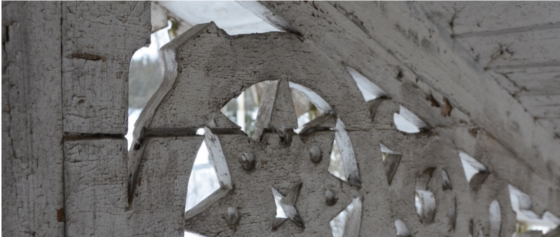
Skarven med not och spont på vänstra sidan av verandan.
