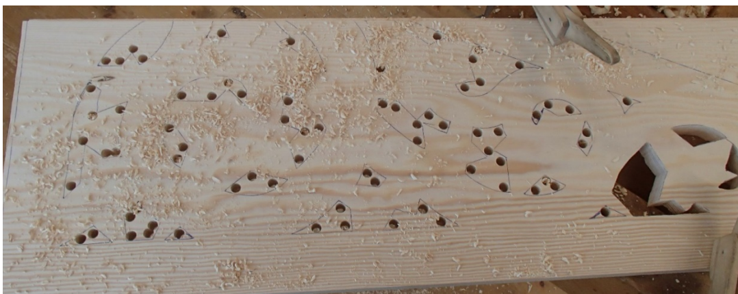
Bild 31. Det är bättre att borra fler hål inför sågning.
