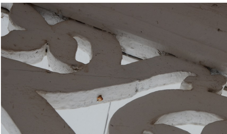
Skarv kant mot kant som sedan är spikad ihop.
