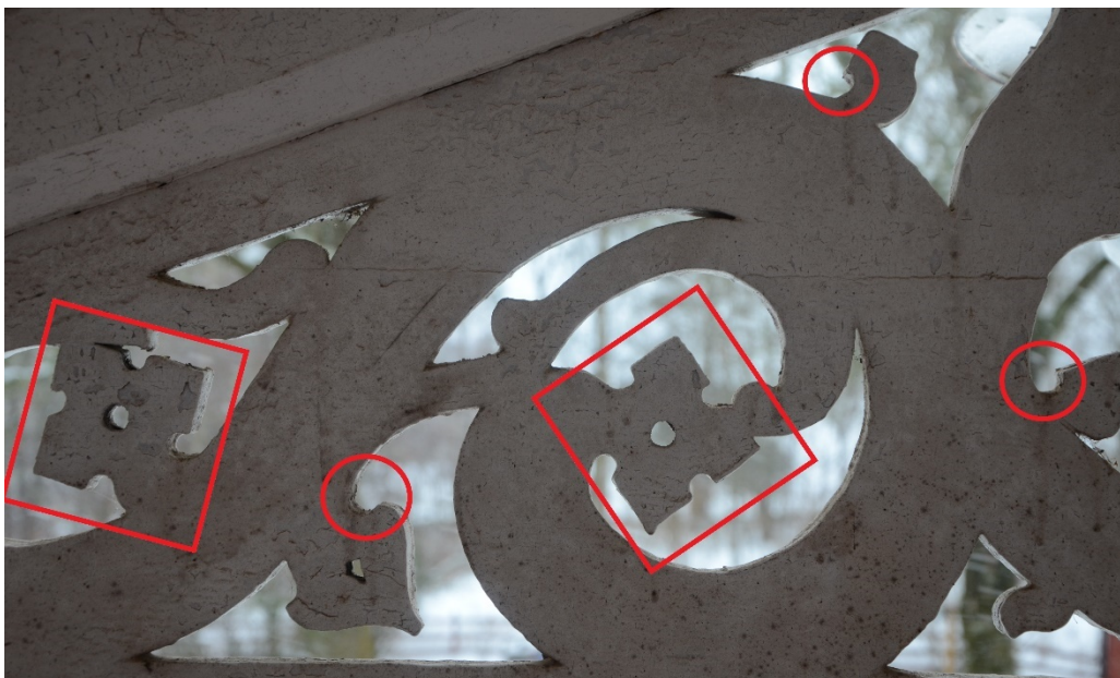
Bild 24. De rödmarkerade områdena visar var man har borrhållat.
