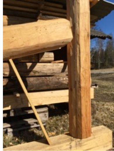
Figur 64. Bilden skall visa hur mycket lutning som behövs för att kunna lyfta in och montera skiftet mellan stolparna. Skiftet vilar mot en timmerbock och en bräda enbart för att ligga kvar i det läge där skiftet precis kan lyftas in mellan stolparna.
