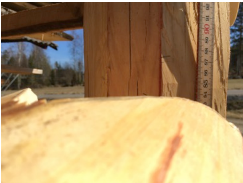
Figur 66. Bilden skall illustrera hur högt skiftets ena ände behövde lyftas för att komma in i ramen. Tumstocken står på syllan och visar att detta skift behöver ca 85 i höjd för att kunna monteras.
