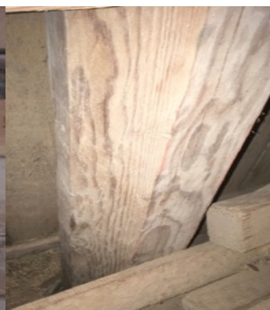
Figur 4. På vinden är den åttkantiga stolpen synlig. Utsidan täcks av stående locklist panel.
