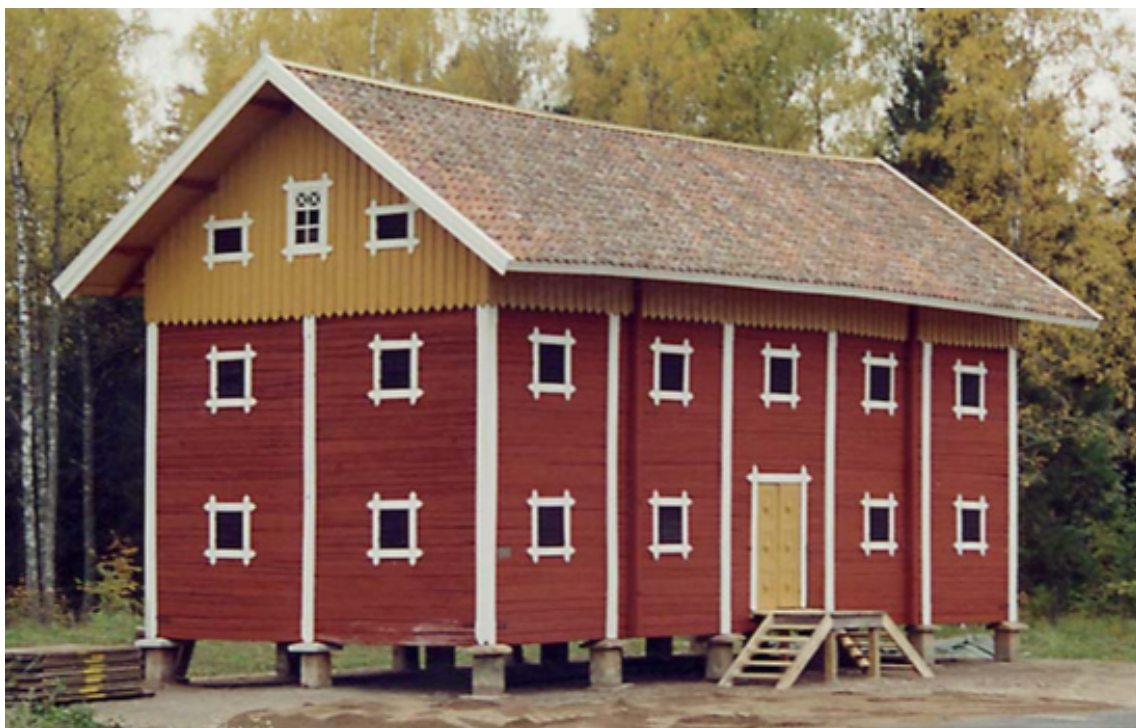
Figur 12. Spannmålsmagasinet i Aspetorp. På bilden kan man se stenplintarna med de karakteristiska mushyllorna som hör ett spannmålsmagasin till. Timmerskiften är rödmålade lika så de två följarna som sitter lodrätt på långsidan. Man kan från utsidan se att skiften är korta då timrets vågräta såtar och sprickor inte fortsätter på samma höjd efter de vita täckbrädorna. Från utsidan döljer täckbrädorna skiftesverkets stolpar. Vindsvåningen täcks av en locklistpanel. Carlquist (2010, s. 23).
