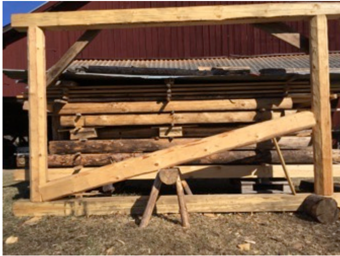
Figur 64. Bilden skall visa hur mycket lutning som behövs för att kunna lyfta in och montera skiftet mellan stolparna. Skiftet vilar mot en timmerbock och en bräda enbart för att ligga kvar i det läge där skiftet precis kan lyftas in mellan stolparna.
