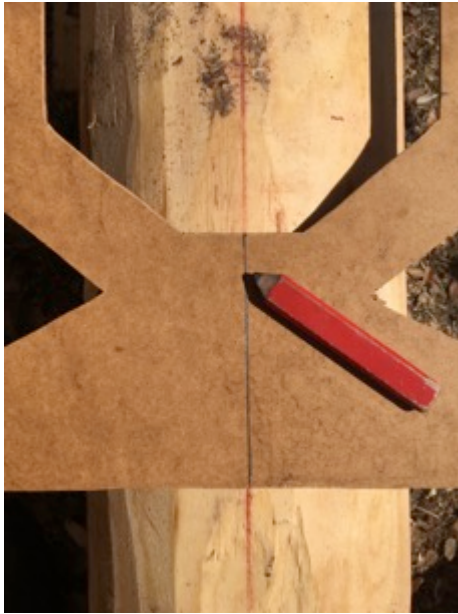
Figur 57. Mallen som har samma form som den åttkantiga stolpen har placerats mitt över skiftet. Strecket på mallen ligger rakt över skiftets centrumlinje.
