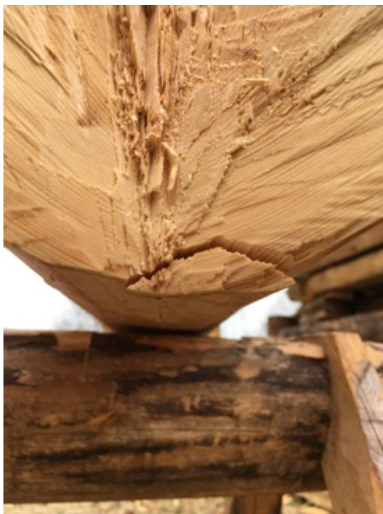
Figur 63. Här har fibrerna bryts av då hela v-formen höggs från samma håll.
