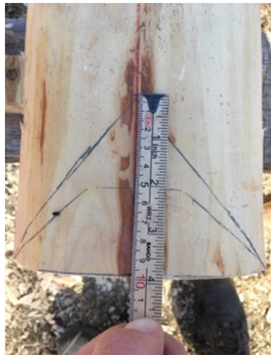
Figur 59. Skiftets v-form görs på olika på de två ändarna. Här görs v-formen 12 cm djup
