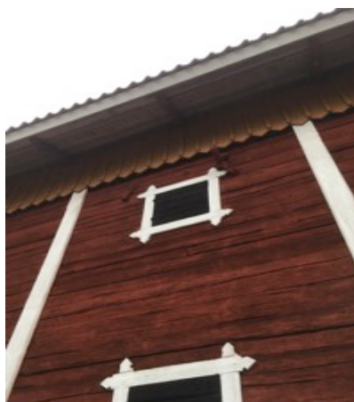
Figur 2. Från utsidan är spannmålmagasinets åttkantiga stolpar helt dolda av vitmålad täckbräda. Det översta skiftet finns i vindbjälklaget och därefter täcks stommens utsida av stående panel.
