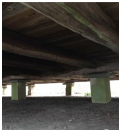
Figur 16. Bjälklaget fick vid renoveringen några nya kalkstensstolpar och här syns två av dem.
