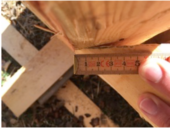
Figur 71. V-spåret som var 10 cm djupt låg tätt emot stolpen.
