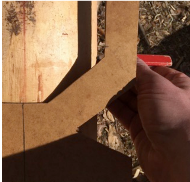
Figur 57. Mallen som har samma form som den åttkantiga stolpen har placerats mitt över skiftet. Strecket på mallen ligger rakt över skiftets centrumlinje.
