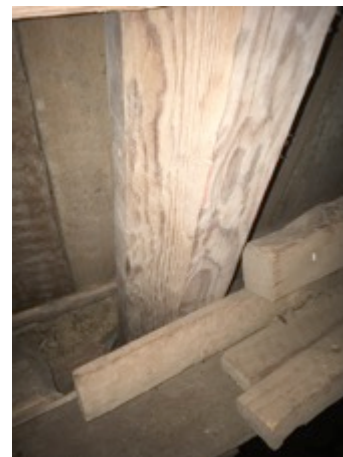
Figur 20. Byggandens hörn sett från insidan. Till vänster och höger ses skift och hörnstolpen med spår ses i mitten av bilden. Hörnstolpe med spår. Stållinjalen användes för att mäta djupet på hörnstolpens spår.
