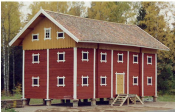
Figur 6. Spannmålmagasinet i Aspetorp (2010, s. 23).
