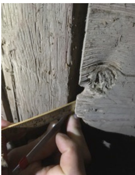
Figur 27. Undersökningen visade att vinkeln på stolpen inte överensstämde med skiftets vinkel. Här ligger ställinjalen platt mot stolpen och tumstocken platt mot skiftets v-spår.
