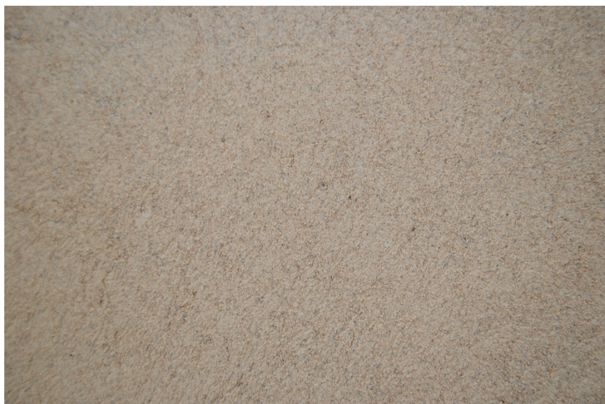
Figur 4 (Foto: Mikel Thorstensen). Puts med skurad yta (puts B).
