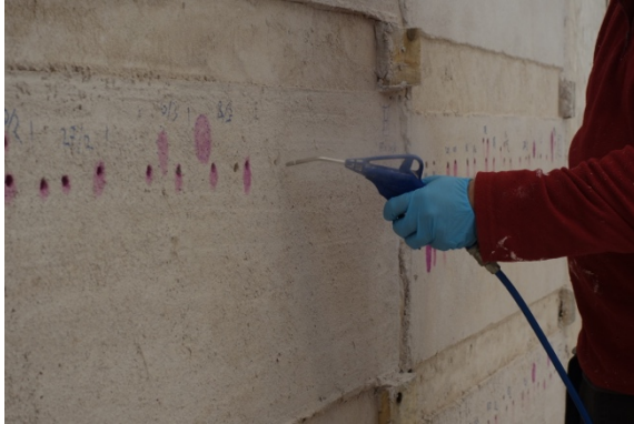
Figur 7 (Foto: Emil Stangenberg) Efter inmätning och borrarng rengörs borrhålet med hjälp av tryckluft.
