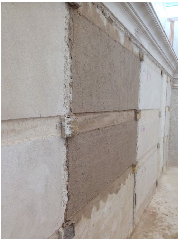
Figur 6 (Foto: Mikel Thorstensen). Putser med avstockade ytor som eftervattnas med två olika intervall.
