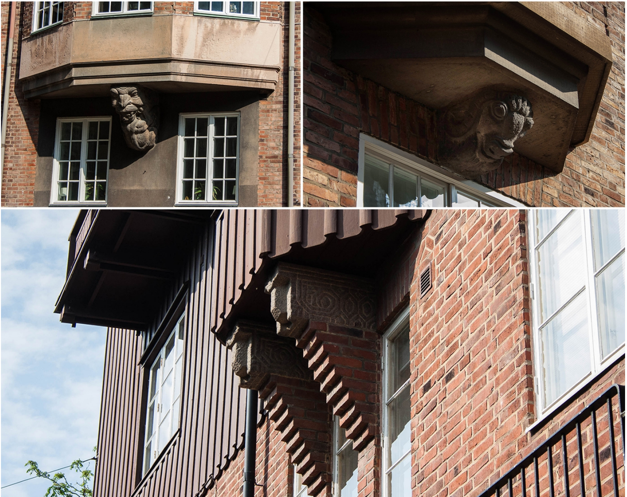
Figur 9. Tre typer av dekorativt huggna konsoler för burspråk. De två övre figurerna förekommer på Erik Dahlbergs-trappan 1 medan den nedre, med mer arkaiserande drag återfinns på Erik Dahlbergsgatan 33. Notera panelbeklädningens enkla men bearbetade utformning och teglets horisontellt rytmska egenskaper. P. I. 2017.
