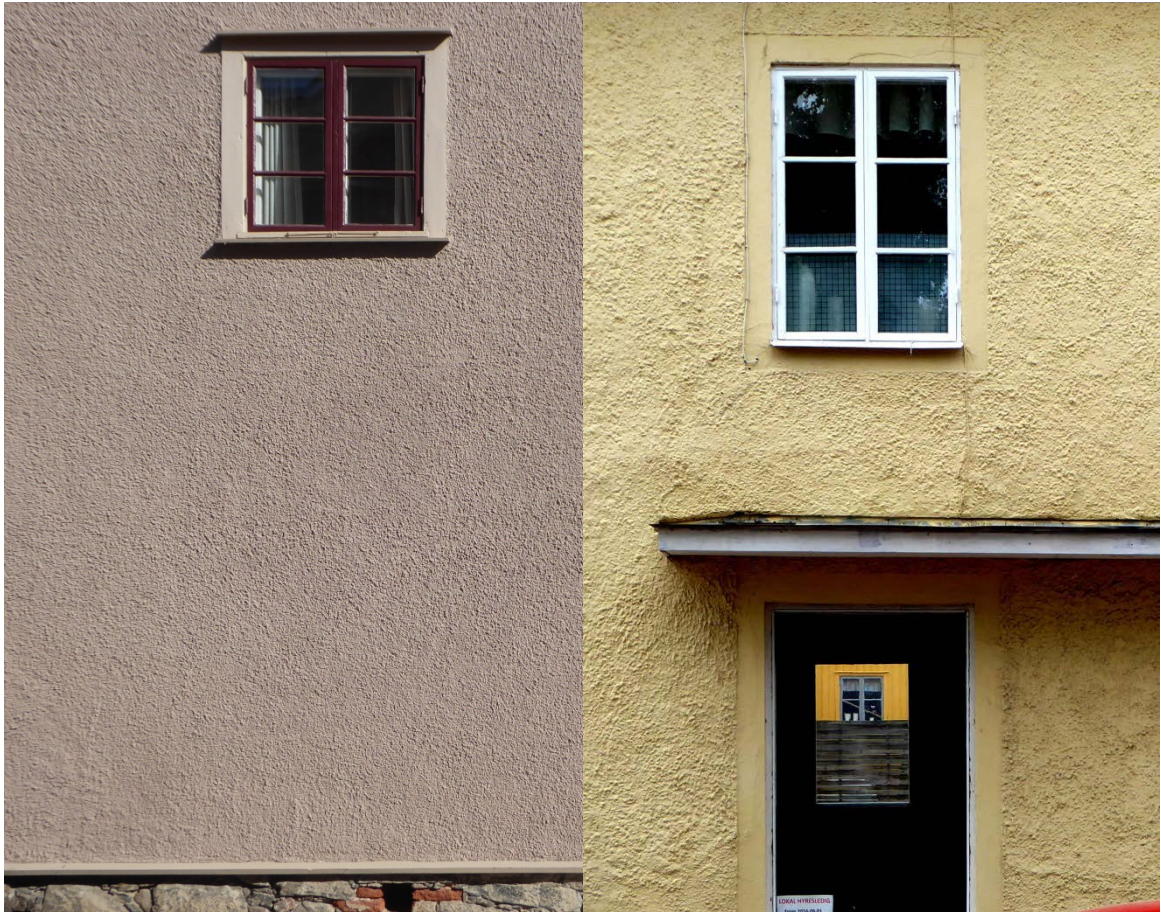
Figur 17. Till vänster: mycket enhetlig ytstruktur. Till höger: oenhetlig ytstruktur.
