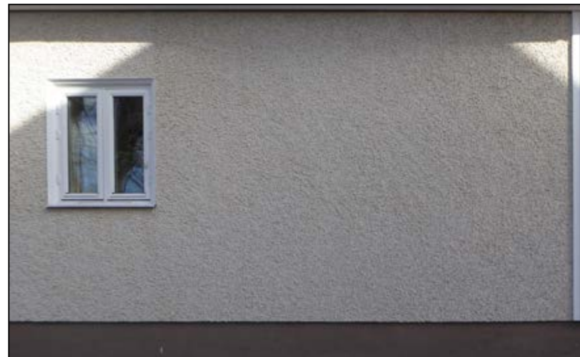
Fig. 1. Helhetsbild. Ytan är extremt enhetlig, i mitten av bilden går det svagt att urskilja diagonala ränder efter appliceringen.
