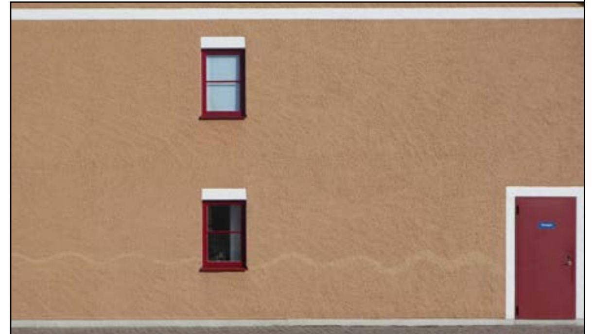
Fig. 1. Helhetsbild. Den ljusa våglinjen långt ner på fasaden är en missfärgning och påverkar inte ytstrukturen något. Jämna bågmönster efter handpåslag syns tydligt.
