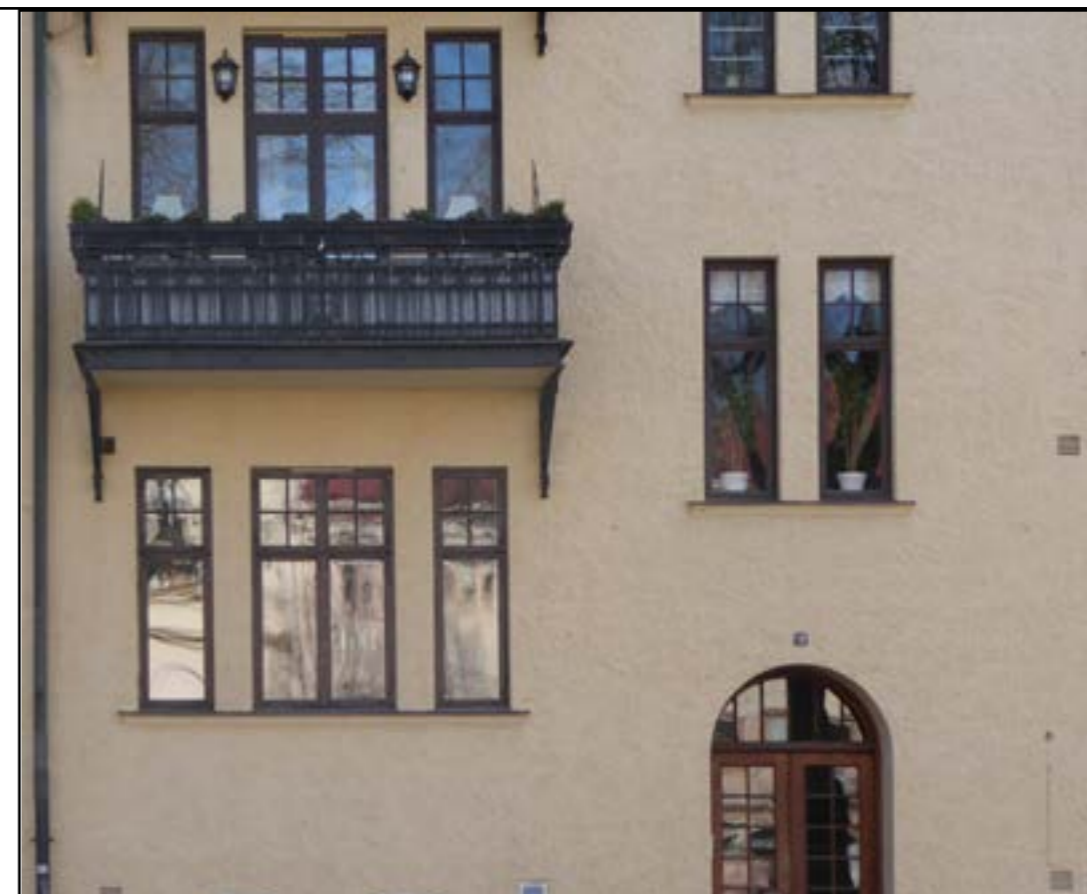
Fig. 1. Helhetsbild. Ytan är enhetlig men ändå livlig på grund av att den är handslagen.
