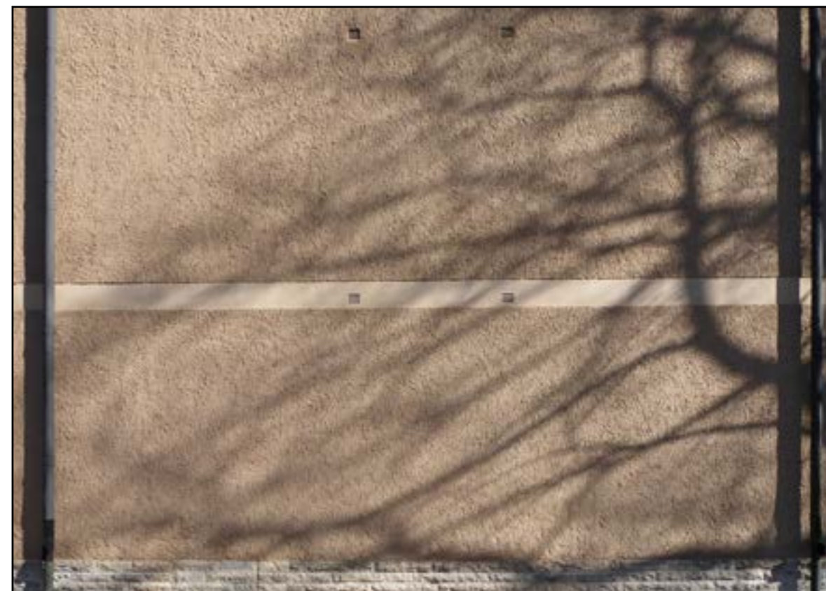
Fig. 1. Helhetsbild. Tyvärr fick vi inte möjlighet att välja vilken fasad vi skulle göra undersökningen då byggnaden låg inne på regemntesområdet så därför blev det mycket skugga i bilden.
