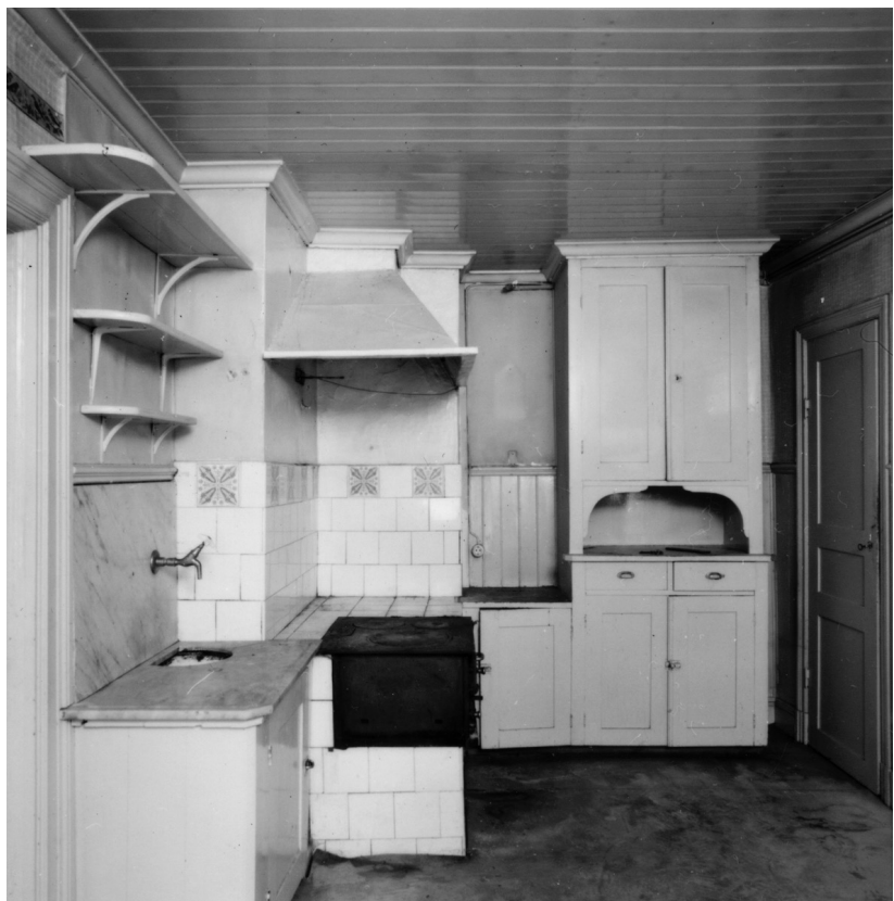
Fig. 3. Ett kök i Gävle som har järnspis, dekorerat kakel, pärlspont, bänkskiva och stänkskydd i marmor, sammanlänkat köksskåp och indraget vatten. Allt som var modernt på 1910-20-tal.
