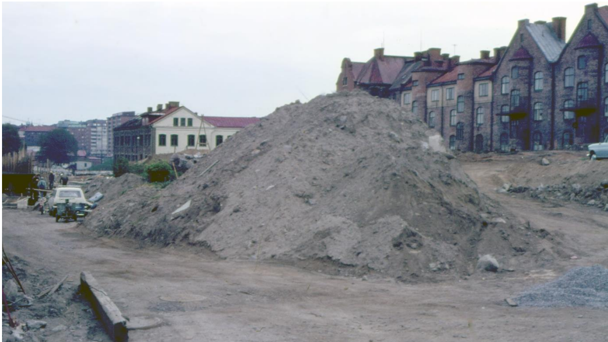
Figur 5. Schaktningsarbeten inför första utbyggnaden av Oscarsgatan i full gång. På platsen stod tidigare ett myller av äldre hus. Det vita huset rakt fram är rivet medan den carnegieska bostadslängan till höger är bevarad men starkt modifierad idag. Foto: Sven Olsson.
