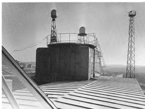
Hisshuset med X- och S-bandsradarstationer på toppen. Från masttornet (nu nedtaget) sträcker sig den rombiska kortvågsantennens trådar till de andra tornen.
