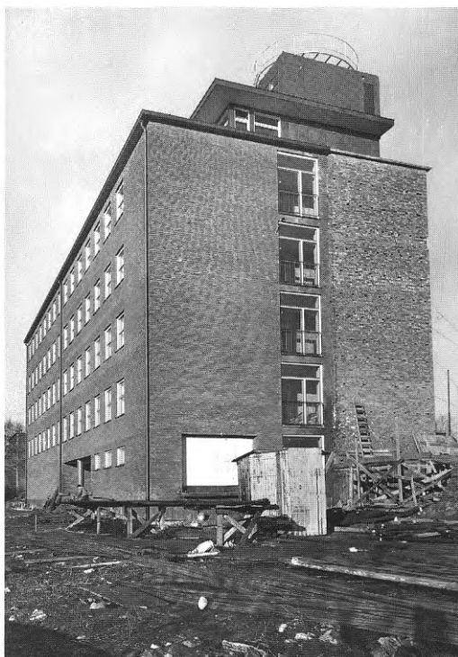
Hisshuset med X- och S-bandsradarstationer på toppen. Från masttornet (nu nedtaget) sträcker sig den rombiska kortvågsantennens trådar till de andra tornen.
