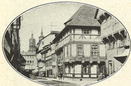
Barfusserstrasse med Junkernhaus.
