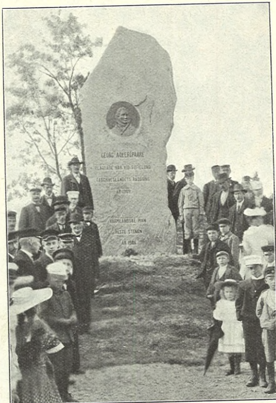
DET NYAFTÄCKTA ADLERSPARREMONUMENTET VID SOFIELUND I VÄRMLAND. LARSEN &amp; EDVALL FOTO.
