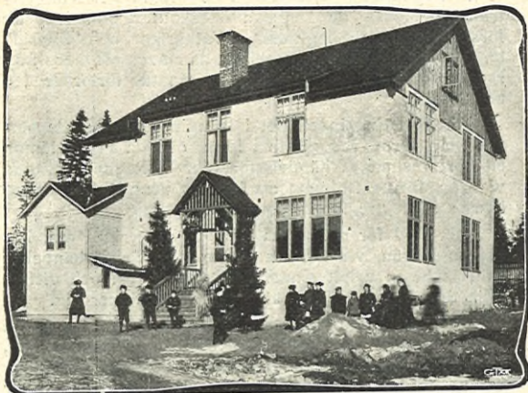
DEN NYA ARBETSSTUGAN VID VÄRTAN BYGGNADENS YTTRE.
