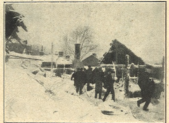
BRANDPLATSEN VID ENGELBREKTSGATAN I GÖTEBORG. I FÖRGRUNDEN DEN NEDBRÄNDA SMEDJAN, LÄNGRE BORT BONINGSHUSEN, TILL HÖGER ÅKERIET, DÄR 7 HÄSTAR INNEBRÄNDES.
