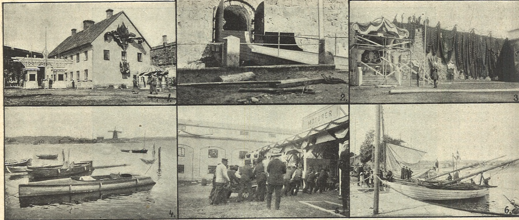
FISKERITUTSTÄLLNINGEN I MARSTRAND. 1. HUFVUDENTRÉN SAMT KOMMENDANTSHUSET, SOM APTERATS TILL ADMINISTRATIONSBYGGNAD. 2. ENTRÉN TILL UTSTÄLLNINGENSOMRÅDET GENOM DEN GAMLA KUNGSPORTEN. 3. DEN STORA SILLVADEN. TILL VÄNSTER GILLBLADSKA FLAGGPAVILJONGEN, FRÅN HVILKEN LANDSHÖFDING LAGERBRING ÖPPNADE UTSTÄLLNINGEN. 4. DIREKTÖR C. O. VERNERS MOTORBÅT »VIKINGEN», SOM TOG FÖRSTA PRISET I KIEL. 5. EN MOTORS INFÖRANDE I MOTORPAVILJONGEN. 6. DANSK FISKMOTORBÅT. OTTO SVENSSON FOTO.
