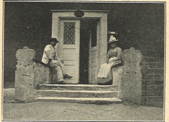
TRAPPAN TILL GÄRDENS POSTSTATION.
