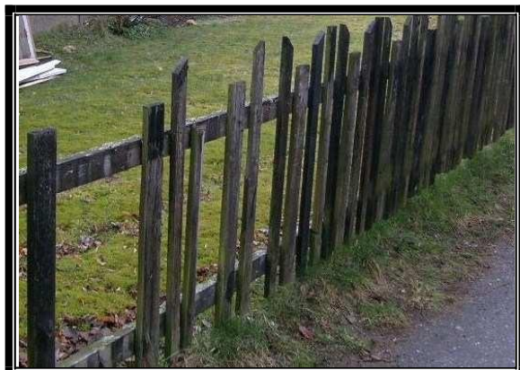
Fig. 20. 2004. Staketet före restaurering. (Informant 1).
