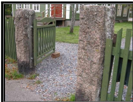
Fig. 21. 2010. Staket och grind efter restaurering.
