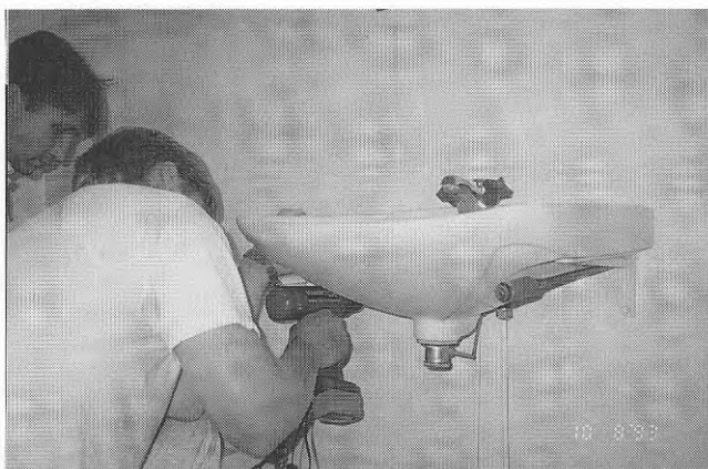
Fig. B6.1 "Målaren" använder här ett egenutvecklat verktyg för att lättare ensam kunna återmontera ett tvättställ.
