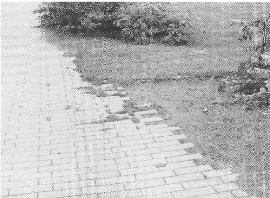
Figur 52. Ojämna och sönderkörda kanter på plattytor förfulade anläggningen och medförde ett ökat behov av ogrärensning i plattskarvarna. (1991)
