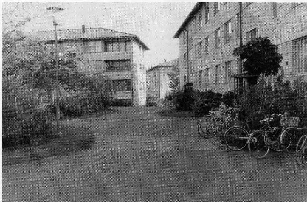
Figur 103. Efter uppbyggnaden har de raka entrévägarna ersatts av böljande asfaltgångar och en mera varierad växtlighet längs med fasaderna. (1990)
