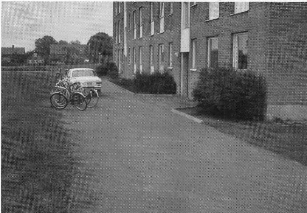
Figur 21. Öppet, blåsigt och med biltrafik ända fram till de oansenligt utformade entréerna, utemiljön före ombyggnaden var tidstypisk. (Foto projektören 1982)
