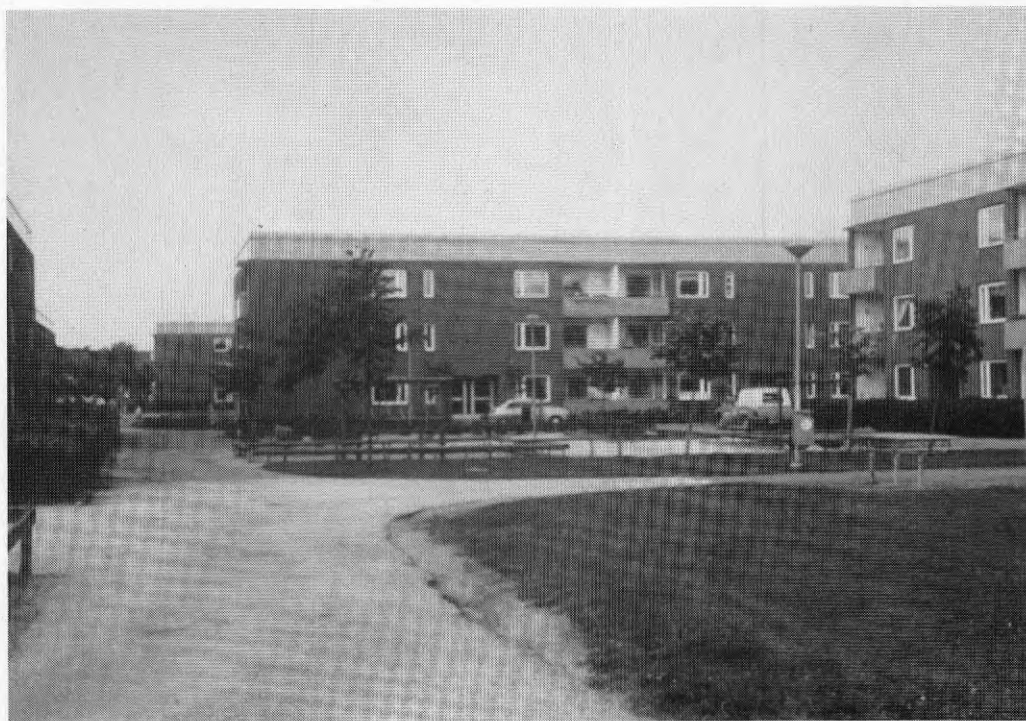
Figur 42. Det var lätt för bilarna att ta sig in på gårdarna före ombyggnaden. (Foto från ansökningshandlingarna 1984)
