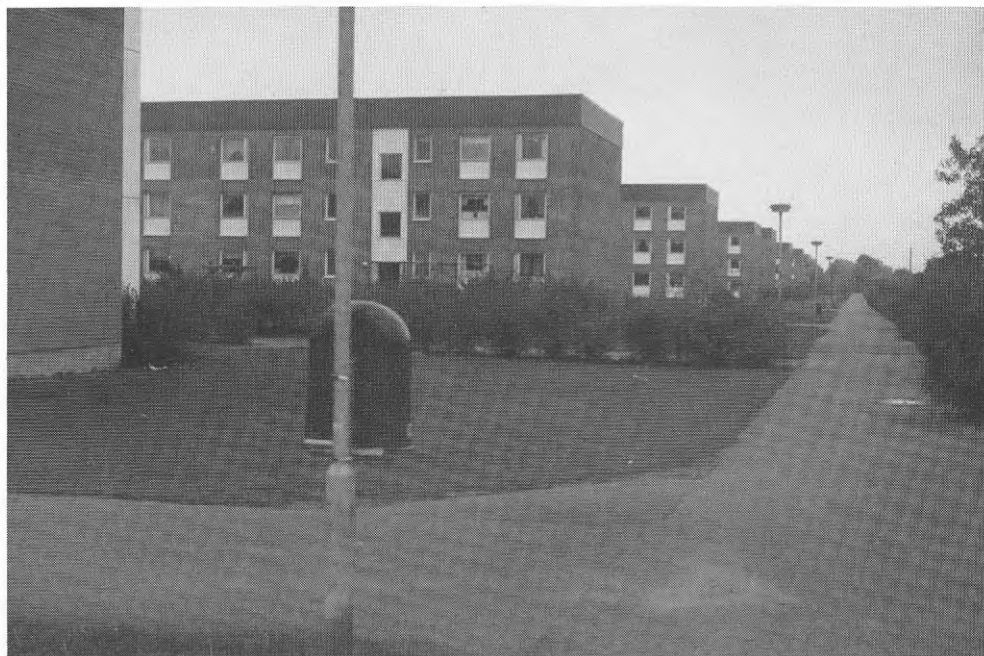
Figur 20. Före ombyggnaden låg gårdarna öppna ut mot den gång- och cykelväg som gränsade till den stora gemensamma parkeringsplatsen mitt i området. I fotot ser man in mot en av de studerade gårdarna, den som ligger längst norrut. (Foto projektören 1982)
