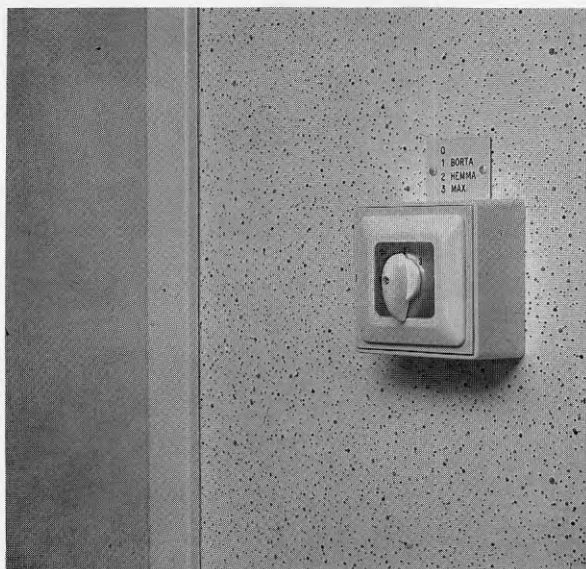
Bild 1.9 Vred för styrning av ventilation.
