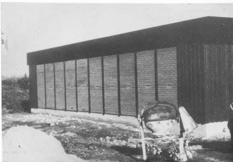
Figur 3:4. Provhusets SV-fasad färdig med provväggar.
