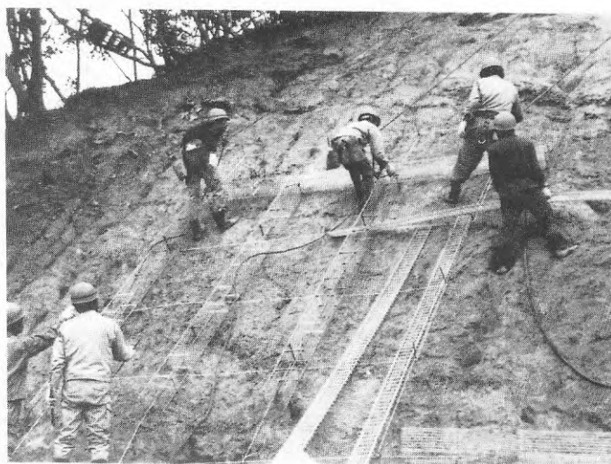
Utförande av släntförstärkning.
