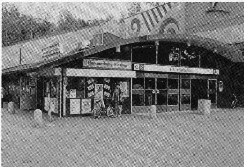
5.9: Spårvagnshållplatsen 16 meter ner i berget utgjorde under en period samlingsplats för stadsdelens ungdomar. För att komma till rätta med de problem detta ledde till installerades en spärrvakt vid nerfarten. Foto: Förf. juli 1992.
