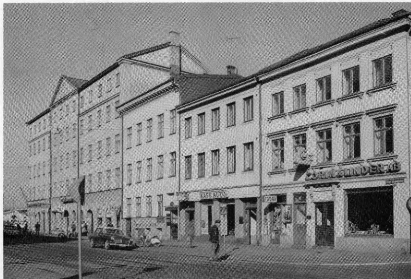
2.2: Östra Hamngatan 2-10. Mitt i centrala Göteborg fick bebyggelsen i Östra Nordstan ge vika för ett kontors- och affärscentrum, det s.k. "femmanhuset". Foto: Göteborgs Historiska Museums arkiv, 1964.
