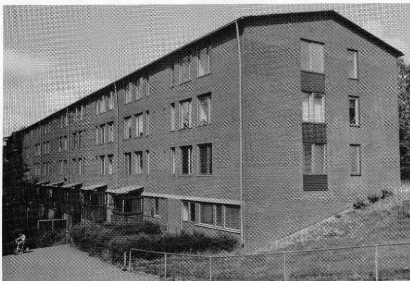
5.1: Området Sandeslätt är byggt kring en kulle där fasaderna utåt är 4-5 våningar, medan fasaderna inåt gårdarna är 3 våningar. Foto: Förf. juli 1992.
