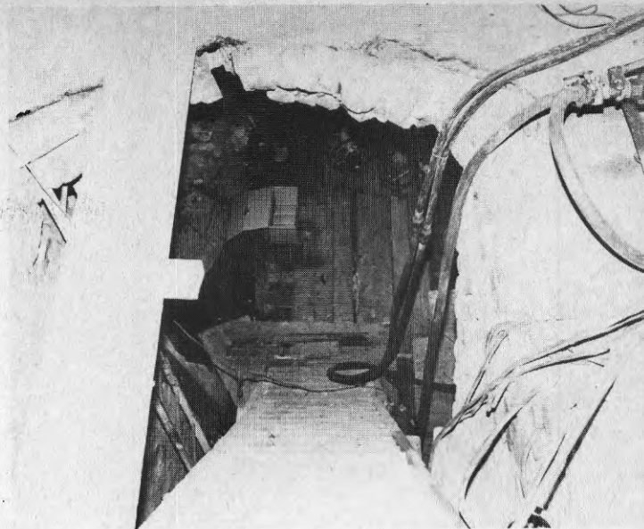
Bild 10: Även transporter inom byggnaden var besvärliga med bl a arbetsnivån långt under gatunivån.
