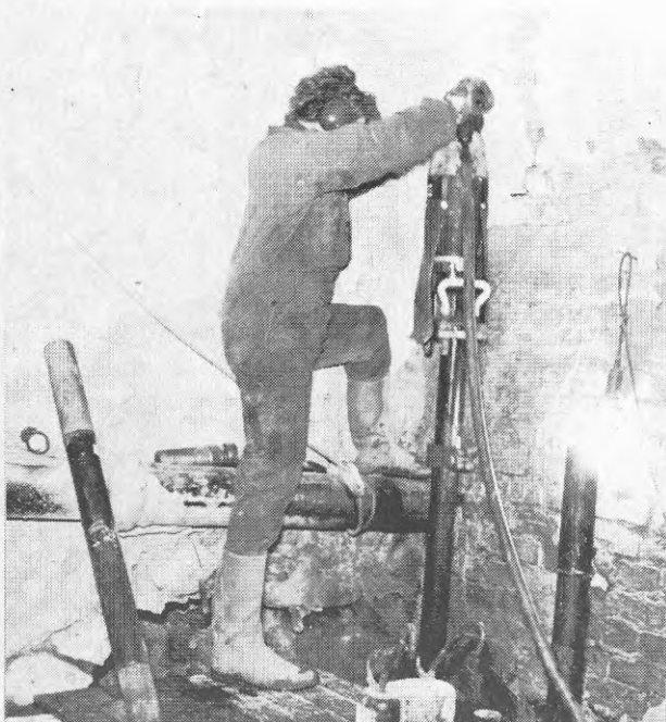
Stålplastpålning. Två man, eller en stark, klarar alla arbetsmoment.
