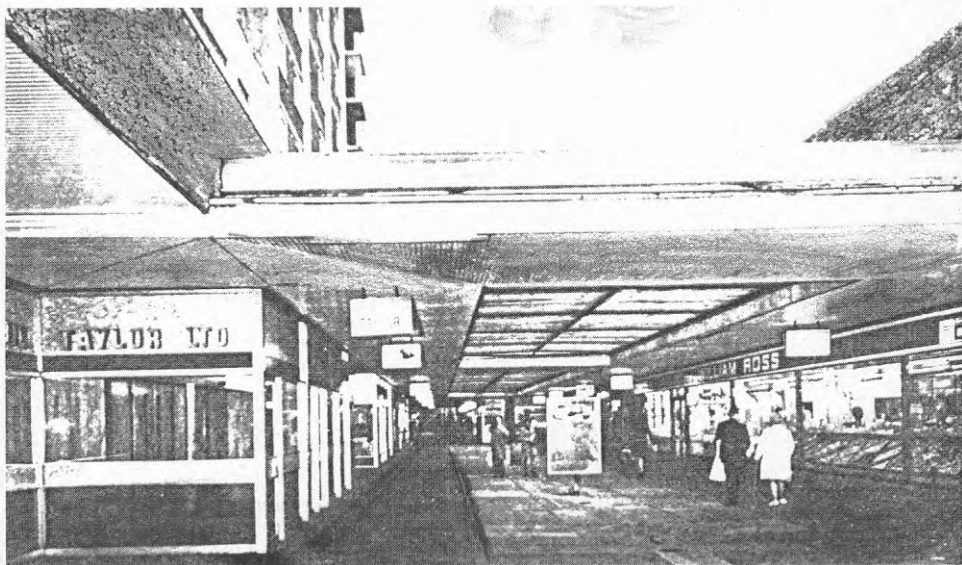
Fig 40. Tak anlagt över gånggata. Efter (18).
