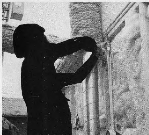
BILD 132-3 Ändring i övrig installation påverkar el-montörens arbete. Flyttning av ventilationstrumman medförde att montören blev tvungen att ta upp nya hål för kabelgenomföringen.
