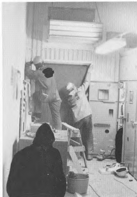
BILD 9-10 Samtidigt med kopplingsarbeten i skåp (sittande montör) utförs plåtarbeten i nära anslutning.
