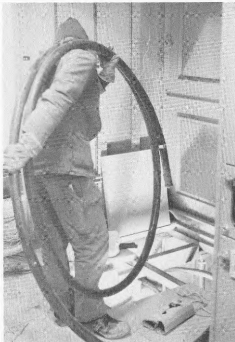
BILD 2 Kabeln matas ner genom golvluckan.
