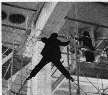
Arbete mellan ställningar
