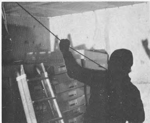
BILD 44-5 Tråddragningen kräver stor kraft, speciellt i detta fall där rördimensionen egentligen var för liten.
