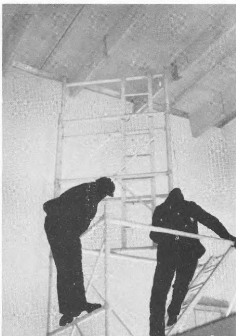
BILD 8 Toppfacket lyfts upp och kopplas samman med mittfacket.
