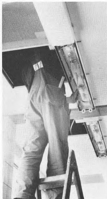
BILD 81-3 Kopplingsarbeten ovanför undertaket medför besvärliga arbetsställningar och dåliga ljusförhållanden.
