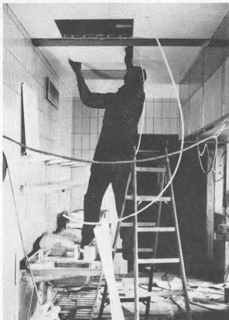
BILD 79 Delar av undertaket måste tas ner när armaturer ska monteras.
