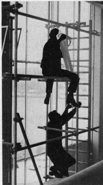
Armatyr lyfts till monteringsstället
