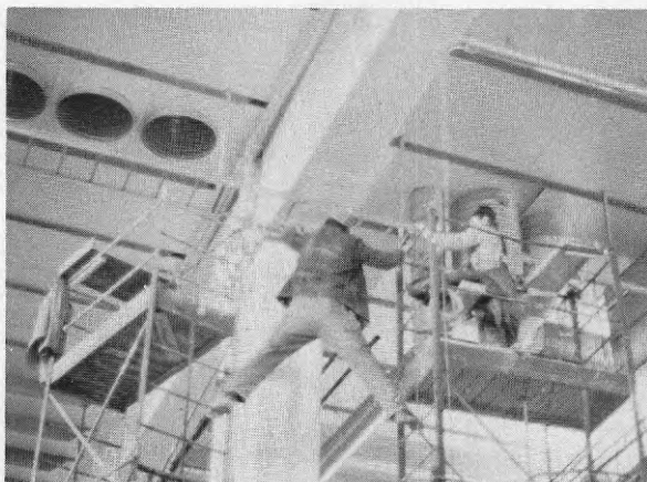
BILD 30 Stagbenen är inte nerskruvade.
