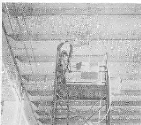
BILD 13 Armaturfäste monteras på lina och kopplas in.
