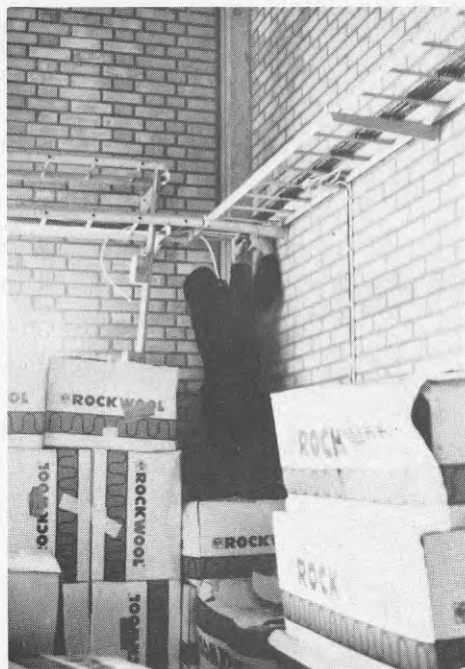
BILD 87-8 Förgreningsdosor monteras på kabelstegen i ett hörn av hallen som nyttjas som upplagsplats för issolering.
