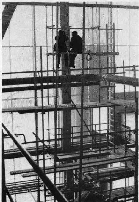
BILD 112 Armaturstag monteras.
