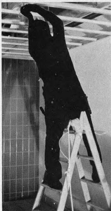
BILD 61-4 Vid rördragning och montering av dosor i tak, från stege, blir arbetsställningen ofta utsträckt och vriden.
