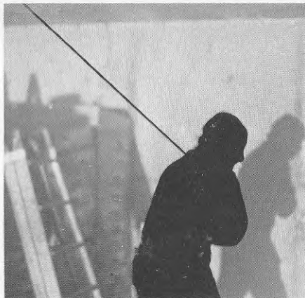
BILD 44-5 Tråddragningen kräver stor kraft, speciellt i detta fall där rördimensionen egentligen var för liten.
