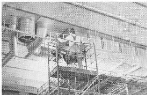
BILD 24-5 Kabelstege hanteras.
