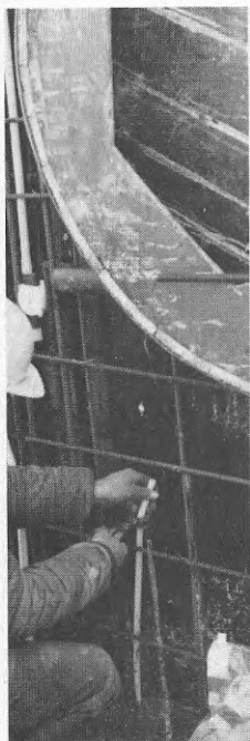
BILD 41 Rör kapas med en specialtång
