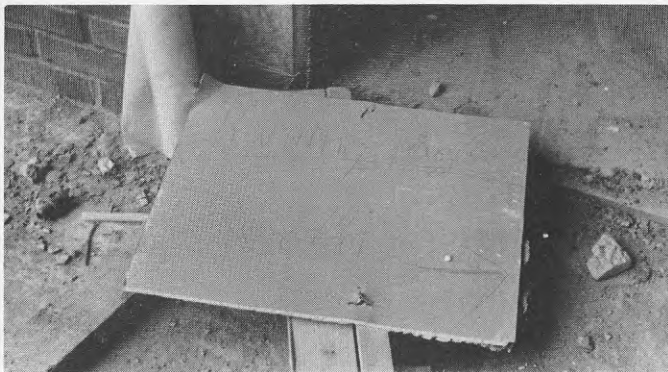
BILD 76 En liggande varningsskylt med otydlig text gör inte stor nytta.
