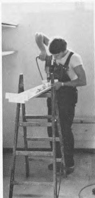
BILD 185 Nya större hål borras för armaturmonteringen.
