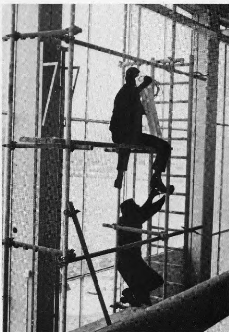
BILD 114-5 Armaturdelar lyfts upp till monteringsstället.
