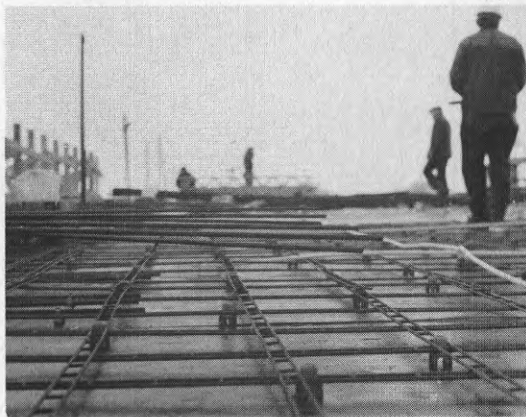
BILD 56-8 Upp- och utstickande armeringsjärn är en stor olycksrisk.
