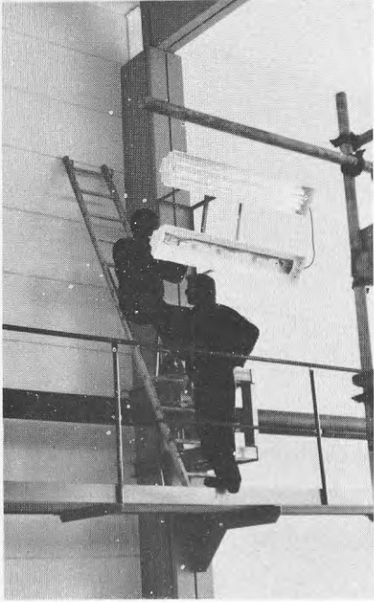
BILD 116-7 Armaturer monteras.
