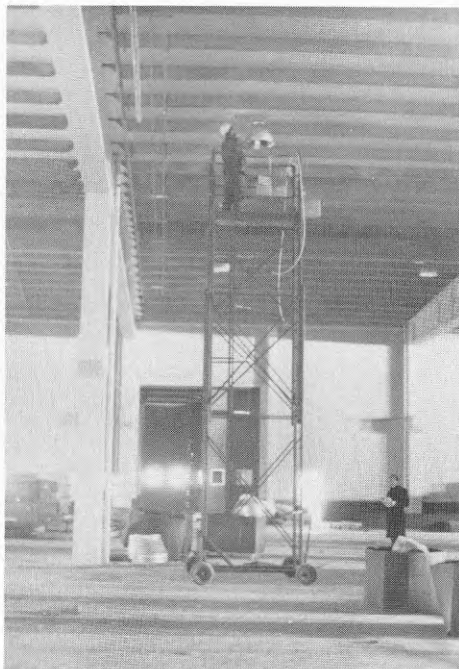
BILD 15 Armaturen monteras.
