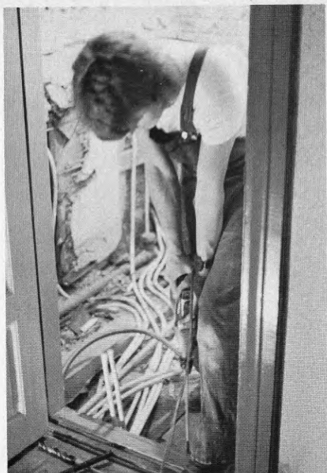
BILD 176-7 Vid ombyggnadsobjekt måste montören oftast borra och hugga upp nya spår för rören.
