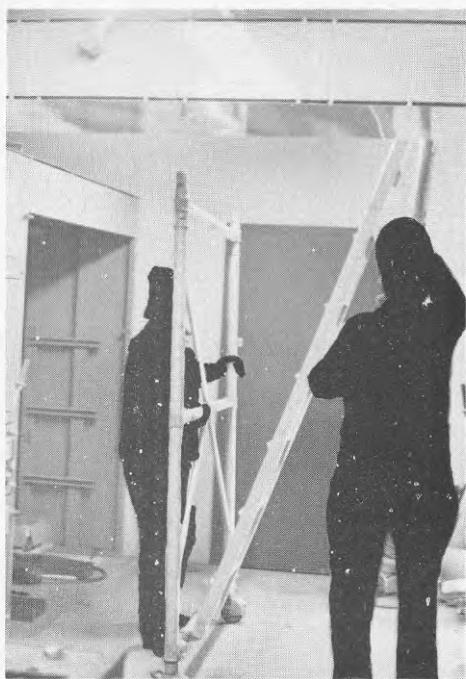
BILD 5 Alluminiumställningens bottenfack placeras i rätt läge.
