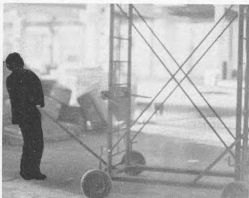
BILD 11 Rätt sätt att flytta en tornställning
