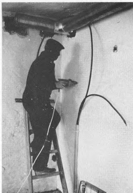
BILD 123 Slagborrning. Ljudstyrkan uppmättes till 103 dB(A). Hörselskydd användes ej.
