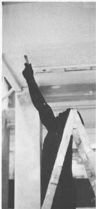
BILD 143 Inmätning av armaturens läge.
