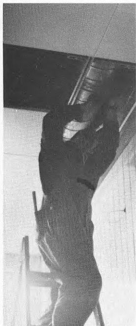
BILD 81-3 Kopplingsarbeten ovanför undertaket medför besvärliga arbetsställningar och dåliga ljusförhållanden.
