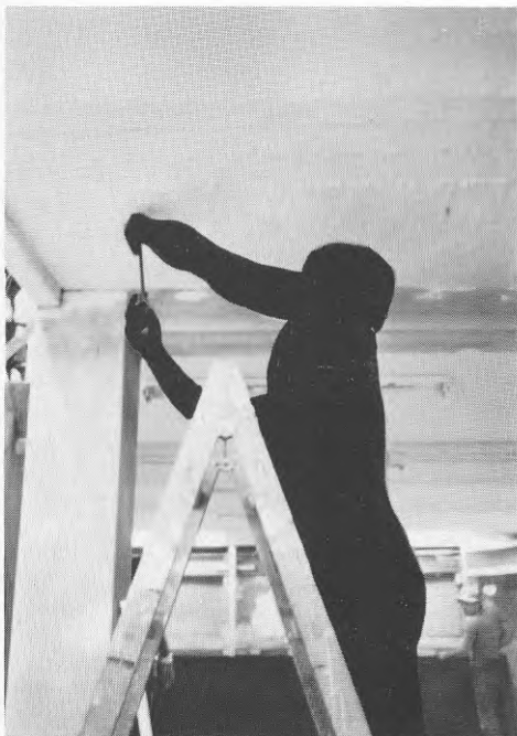
BILD 146 Iskruvning av fästskruvar.
