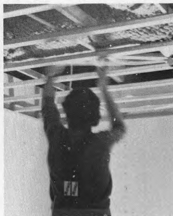
BILD 61-4 Vid rördragning och montering av dosor i tak, från stege, blir arbetsställningen ofta utsträckt och vriden.
