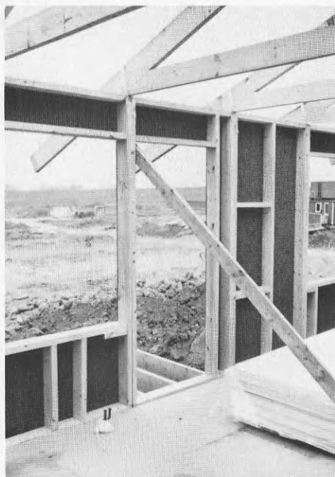
BILD 136-7 Inget skyddsräcke vid balkongöppning - fallrisk.
