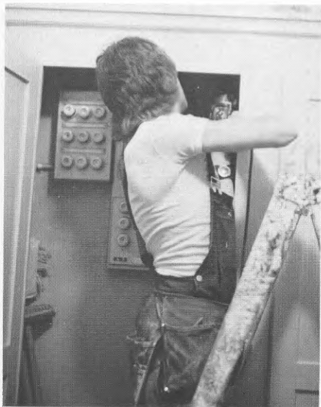
BILD 183 Rör dras till ett befintligt skåp i lägenheten under lägenheten som byggs om.
