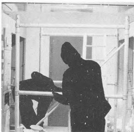
BILD 6 Bottenfacket kopplas samman med strävor.
