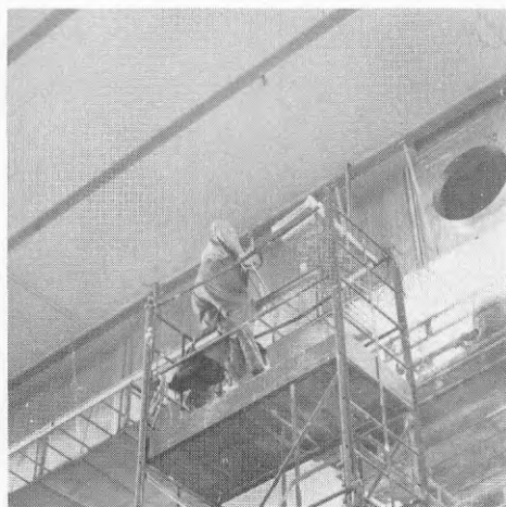
BILD 26 Kabelstege kapas.
