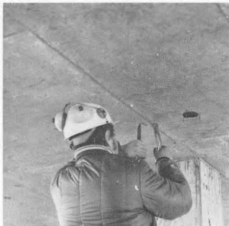
BILD 35 Rensningsarbetet utförs med kniv och hovtång.
