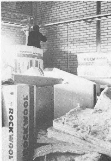
BILD 87-8 Förgreningsdosor monteras på kabelstegen i ett hörn av hallen som nyttjas som upplagsplats för issolering.
