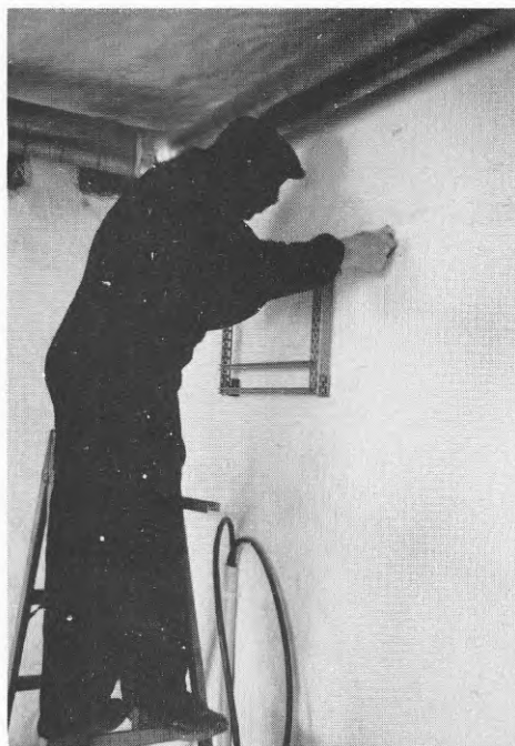
BILD 125 Ramen skruvas fast.
