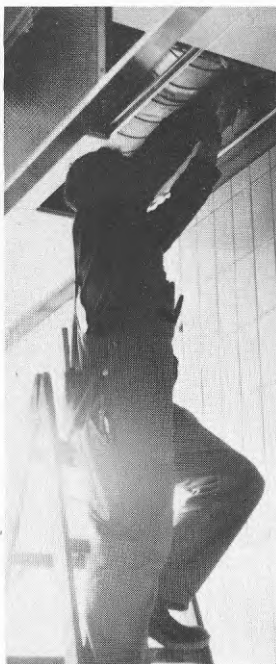
BILD 81-3 Kopplingsarbeten ovanför undertaket medför besvärliga arbetsställningar och dåliga ljusförhållanden.
