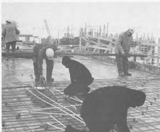
BILD 50 Rördragning på valv sker ofta samtidigt med armeringsjobb.
