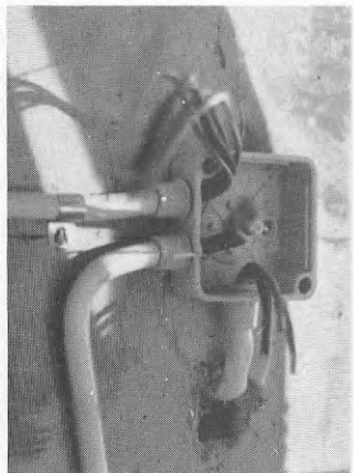
BILD 47-9 Kopplingsdosorna är ofta onödigt små och placeras ofta svåråtkomligt.
