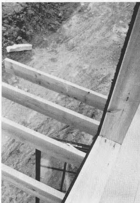
BILD 136-7 Inget skyddsräcke vid balkongöppning - fallrisk.
