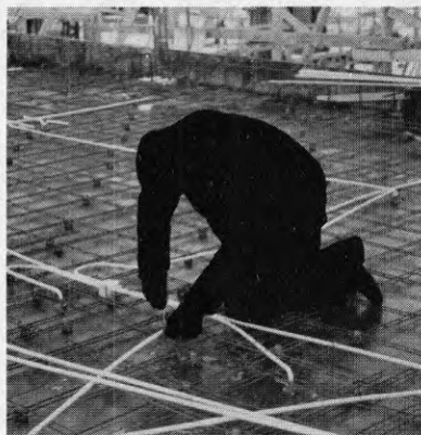
Rördragning på valv
