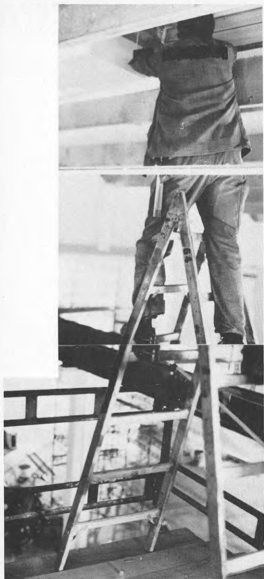
BILD 84-5 Rök luckornas öppningsmekanism monteras från en på ställningen stående steg.
