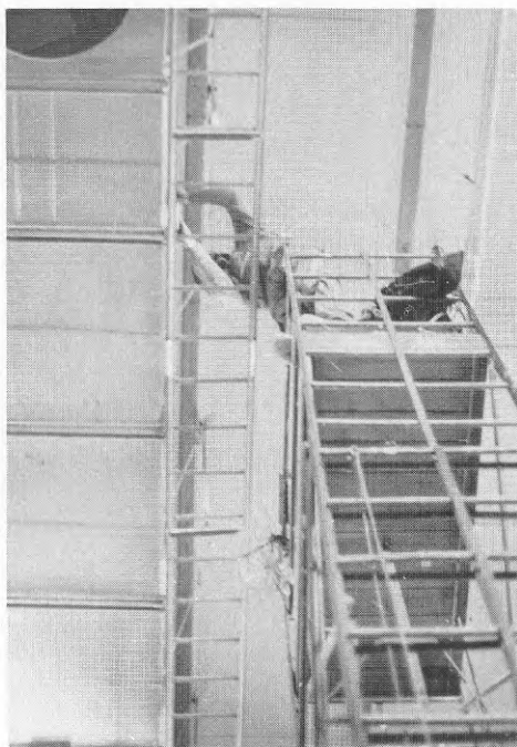
BILD 27 Kabelstege monteras.
