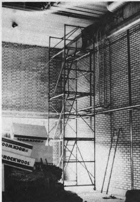
BILD 92 Vid kabeldragning måste montören klättra mycket i ställning.
