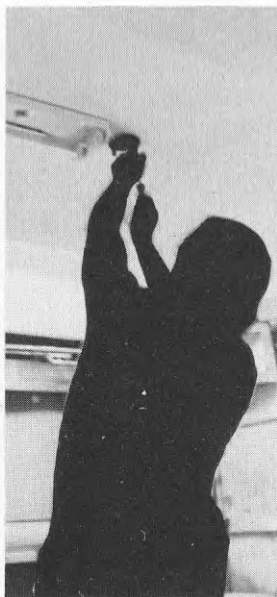
Montering av dosa i tak
