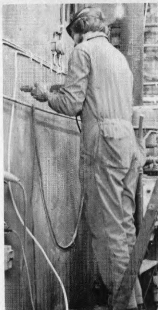
BILD 172-3 Ny kabel monteras på betong- vägg.
