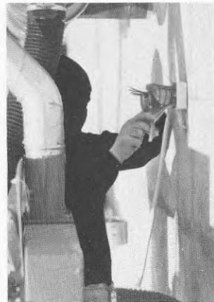
BILD 47-9 Kopplingsdosorna är ofta onödigt små och placeras ofta svåråtkomligt.
