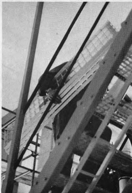
BILD 113 Armaturdelar bärs upp.
