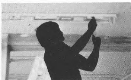
BILD 148 Armaturen skruvas fast.
