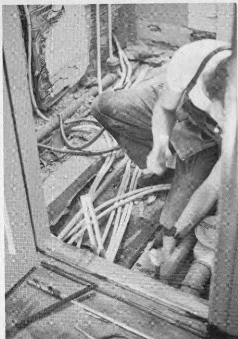
BILD 176-7 Vid ombyggnadsobjekt måste montören oftast borra och hugga upp nya spår för rören.
