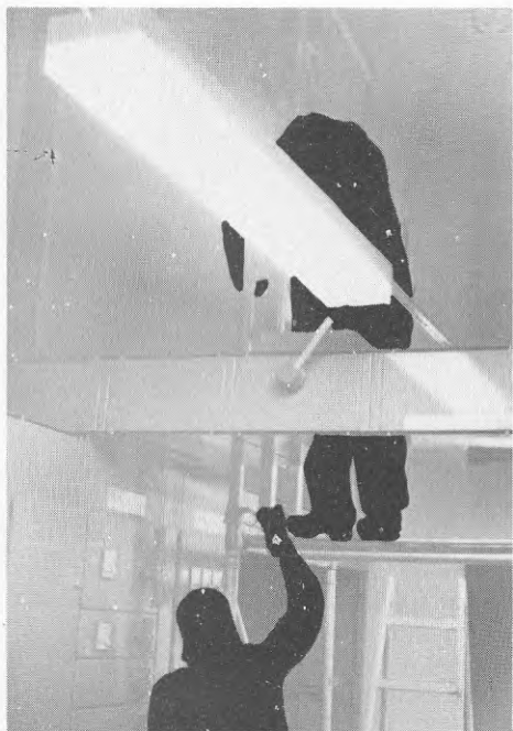
BILD 7 Mittfacket lyfts upp och kopplas samman med bottenfacket.
