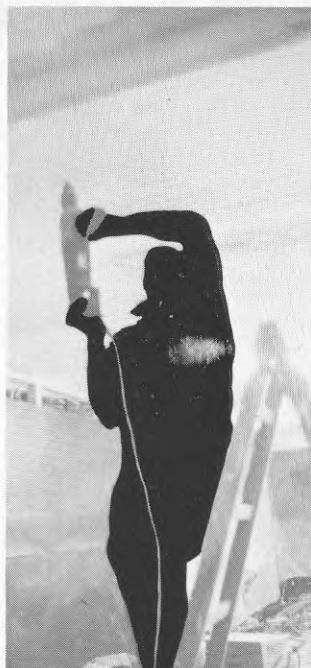
BILD 145 Slagborrning. Ljudstyrkan uppmättes till 104 dB(A). Varken hörselskydd eller andningsskydd användes.
