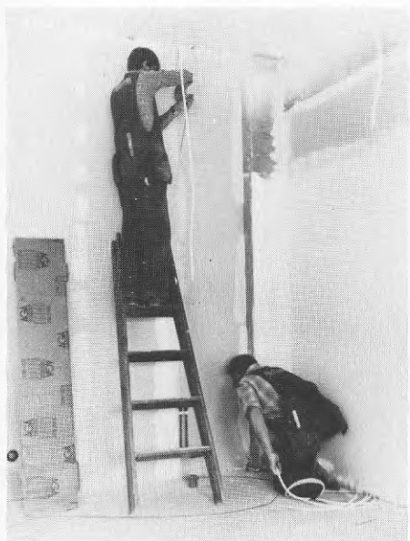
BILD 166-9 Ex. på arbetsställningar vid koppling av dosor och dragning av tråd.
