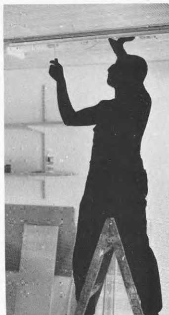
BILD 187 Armaturen skruvas fast.
