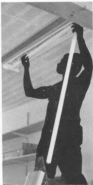
BILD 189 Lysrör monteras.
