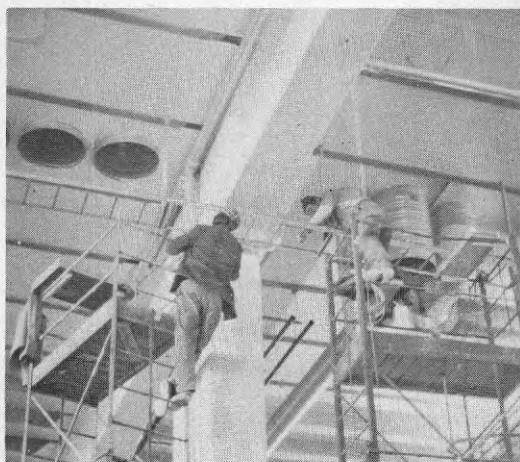
BILD 29 Kabelstege monteras under balkar.
