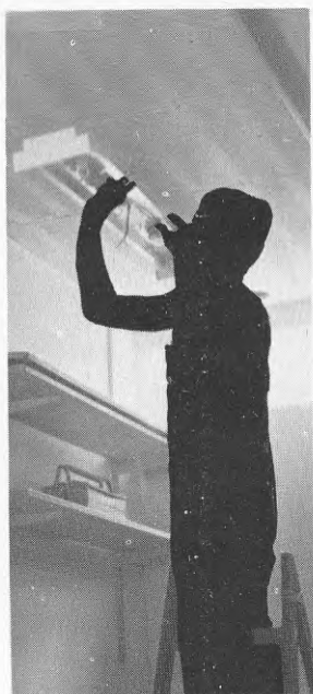
BILD 186 Armaturen placeras i rätt läge.
