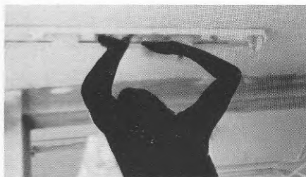
BILD 147 Armaturen lyftes upp och hakades på.
