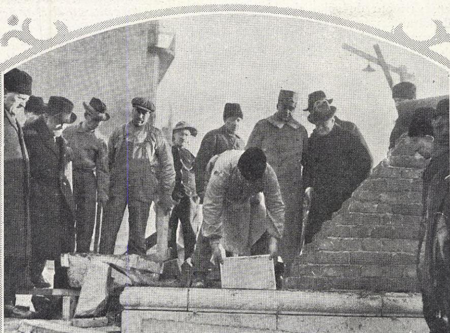
"Bygge och Bo" hålles i år i ett ståtligt nyuppfört hus, Norr Mälarstrand 26, som sedan utställningen är över, skall förvandlas till ett vanligt bostads- och affärskomplex. Grundstensnedläggningen, som återges här ovan, skedde den sista januari. Huset byggdes sedan med amerikansk fart, så att taklagsölet kunde firas redan efter två månaders tid.
