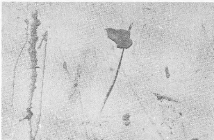
B 1b Måttliga skador, skadans yta 1 - 5 cm 2 och djup mindre än 3 mm.
