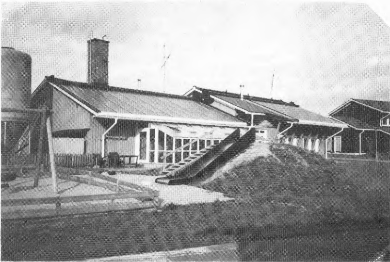
Figur 1.1 Pelletstank och takintegrerade högtemperatursolfångare.
