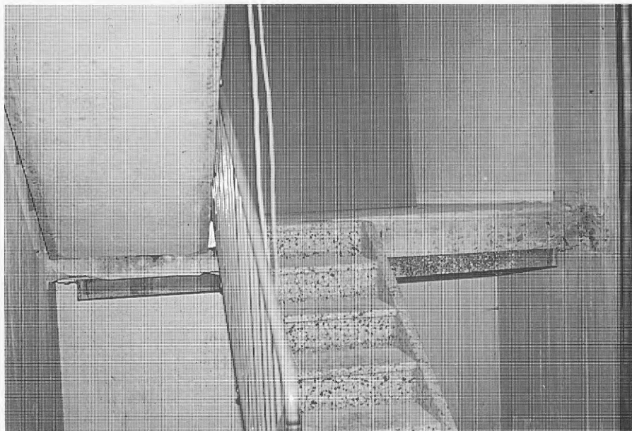
FIG. 30 Ombyggnad med smala trappor och plats för hiss.
