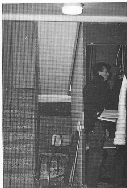
FIG. 32 Trapphus efter ombyggnad.
