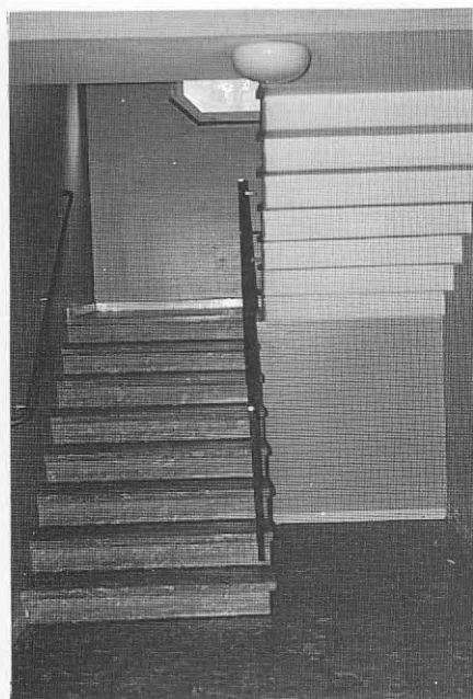
FIG. 31 Trapphus före ombyggnad.
