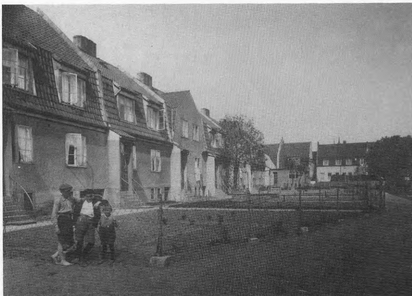
Kv Ören, radhusens "andra" entrésida mot kvarterets inre (Ek-saml).
