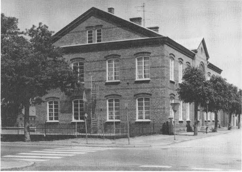
Södra Skolan, nedan tegeldetalj.
