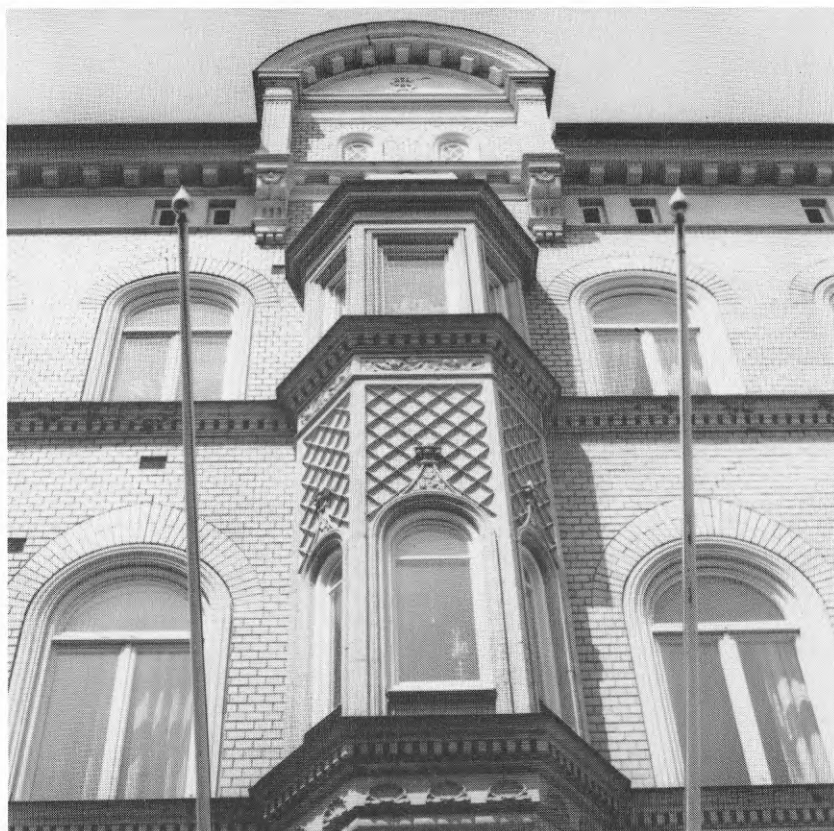
Kvarteret Ubbe 6, detalj av fasad.
