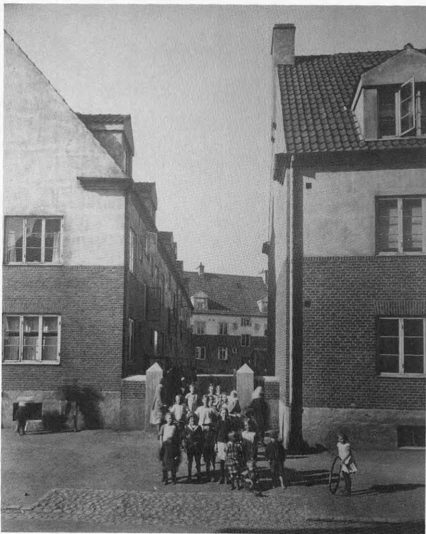
Husen vid Fröjdenborgsgatan, öppning mot inre gårde (Ek-saml).
