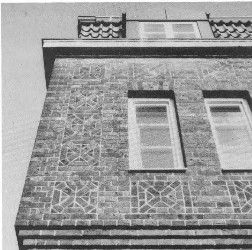
Kv Nimrod 26, burspråk mot Föreningsgatan.
