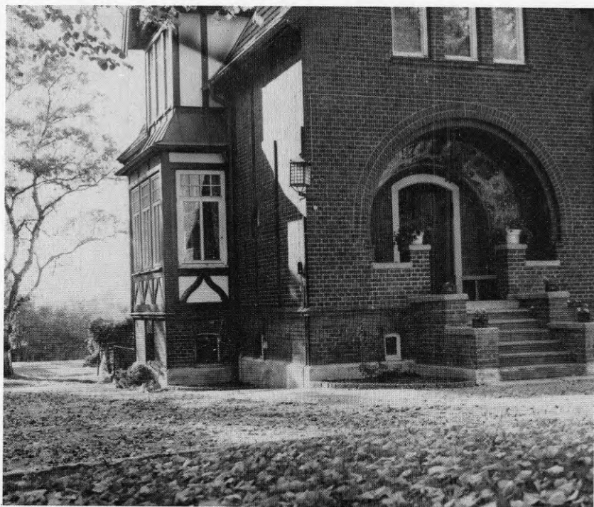
Villa i Kv Boken, entrén.
