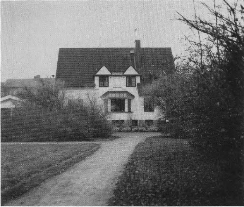
Tenaljen 1, fasad mot Vallvägen.
