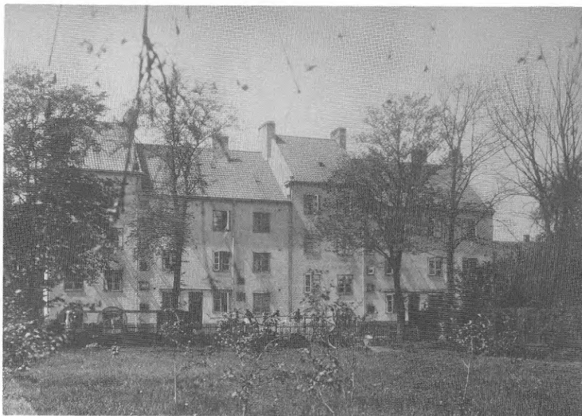
Kv Friden 32, före ombyggnaden (Ek-saml).
