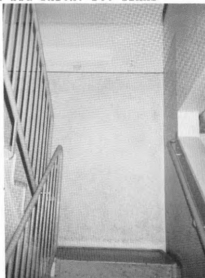
Målad vägg i trappuppgång
