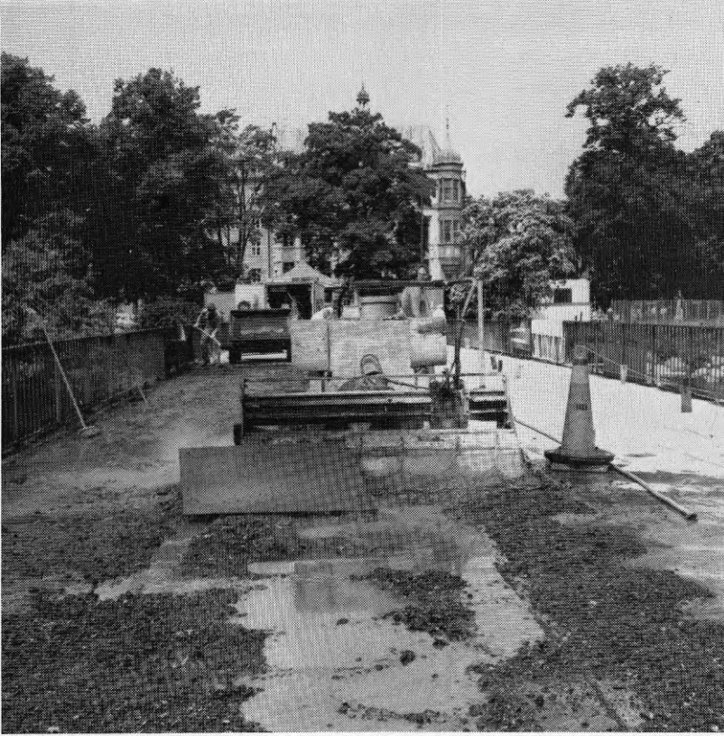
Fig 4.41 Vattenbilning av gjutasfaltbeläggning på Kaptenbron i Malmö.
