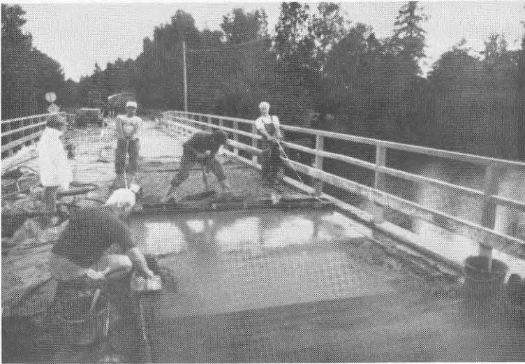
Fig 4.13 Pågjutning av ny brobanebetong.
