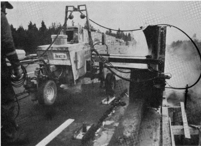
Fig 2.5. Utrustningen monterad för "utvändig" vertikal bilning. Används på kajmurars och brobanekantbalkars utsida.
