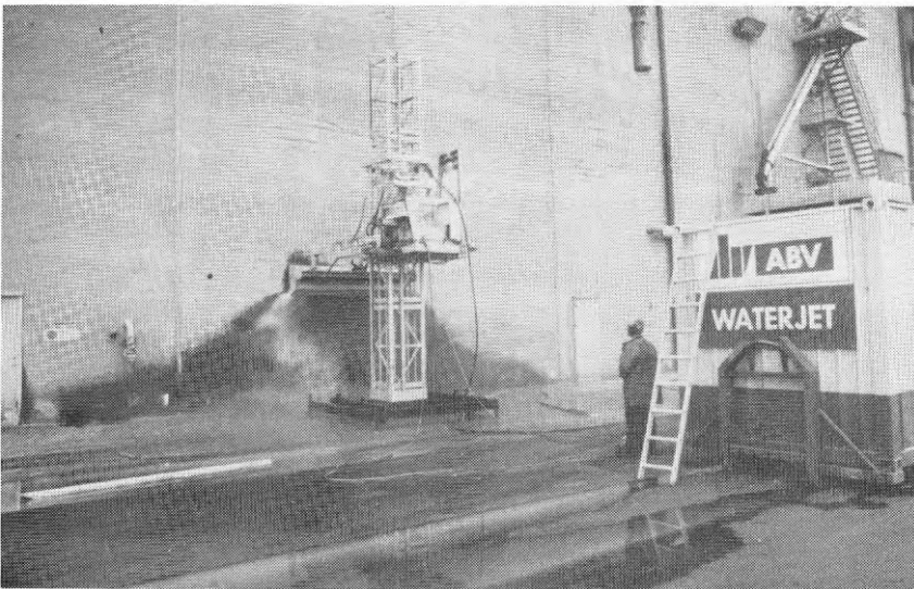
Fig 4.22 Vertikal vattenbilning på silovägg.
