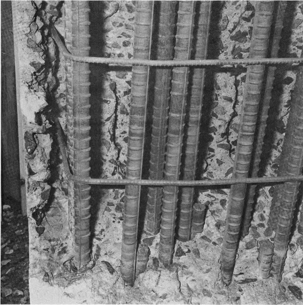
Fig 4.59. Detalj från färdig, vattenbilad ursparing, visande nedre vänstra delen av ursparing 1. Största avverkningsdjup 540 mm.
