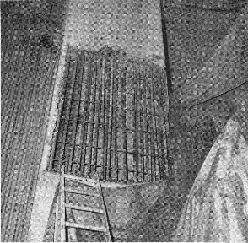
Fig 4.56 Ursparing 1 efter avslutad vattenbilning.
