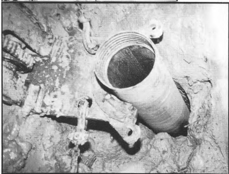
BILD 5. Färdigborrat hål med större diameter än foder-röret.
