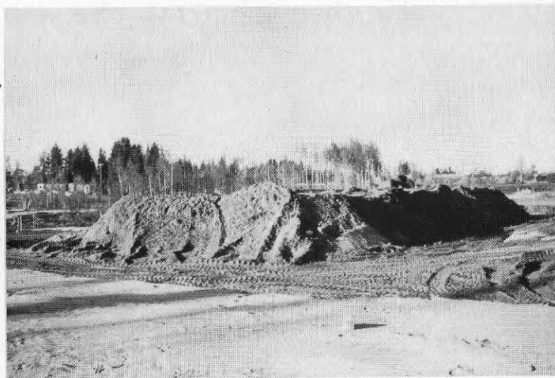
Figur 4.7 Överlasten påförd.
