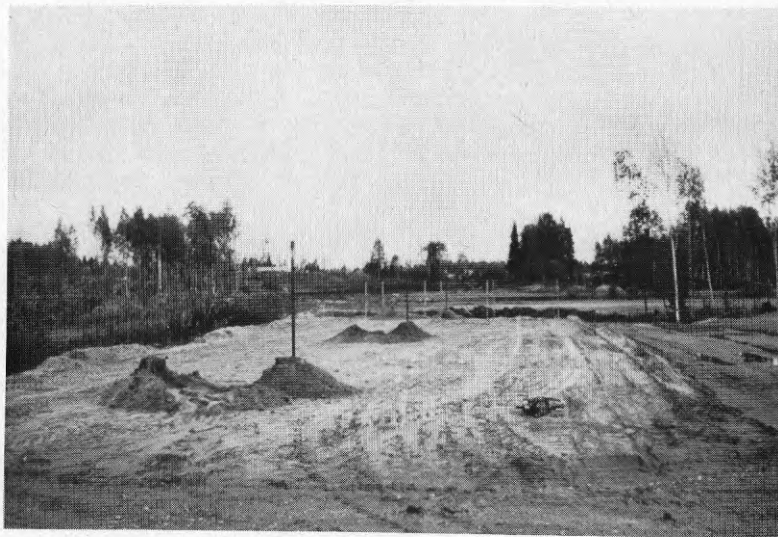
Figur 4.6 Sättningsmätare installerade.
