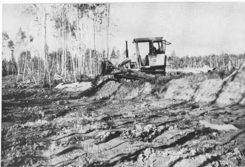
Figur 4.5 Utplacering av fyllnadsmassor.
