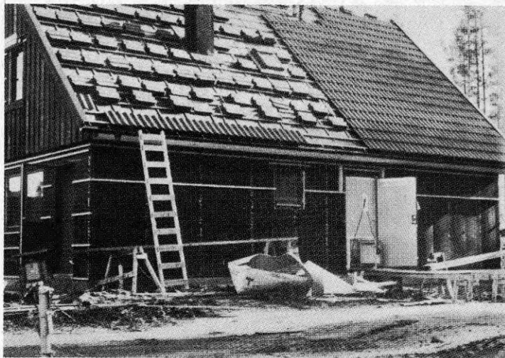
BILD 1 Provhuset i Skutskär - Ett av de tidigast provade husen.
