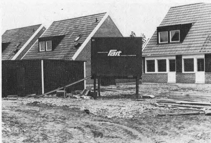
FIG 12. FA:s miniburk uppställd på bygg- arbetsplats
