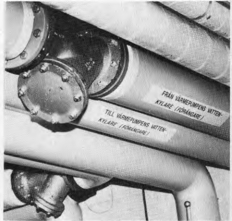
17 Värmepumpsrör
