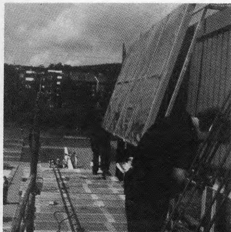
6 Montering av solfångare på fasad
